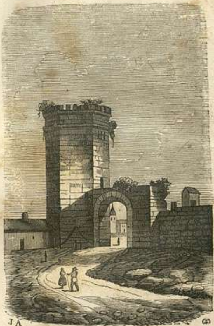
Torre y Puerta de la Marmuerta en Córdoba.
