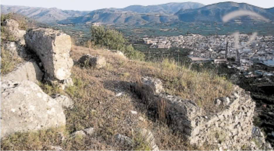
Foto 137. Recinto interior desde donde se contempla la actual ciudad de Pego.
