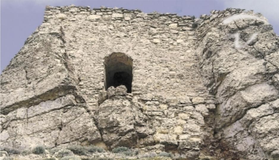
*Foto 59.* Igualmente, utilizando los elementos naturales, se elevaban sus cuerpos o torres cerrando con mampostería sus huecos.
