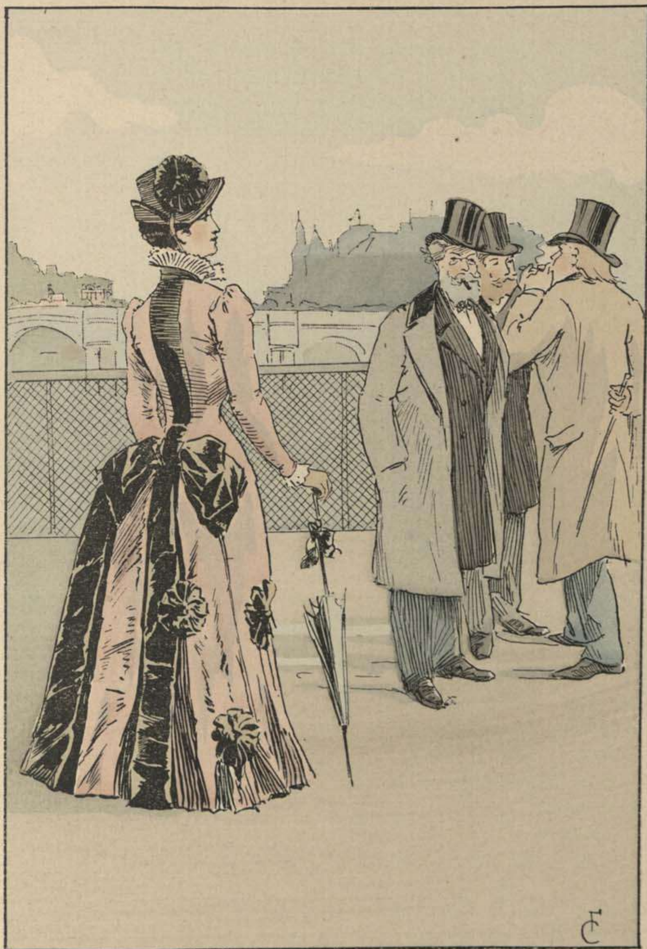
A LA SORTIE DE L'INSTITUT Le pont des Arts en 1884.
