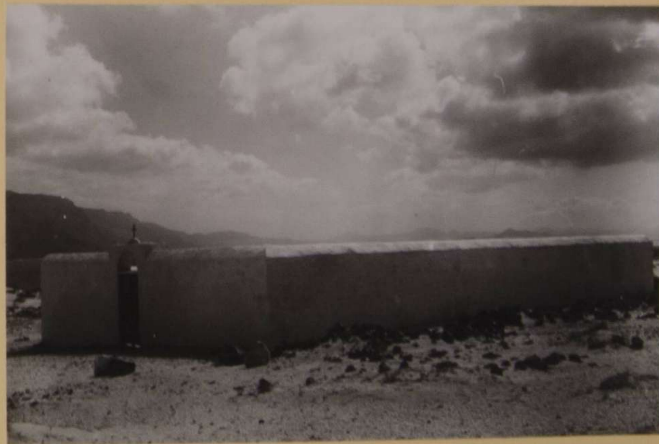
VISTA DEL CEMENTERIO CONSTRUIDO EN LA ISLA GRACIOSA. COSTO PTAS. 12.000. - AÑO 1943.
