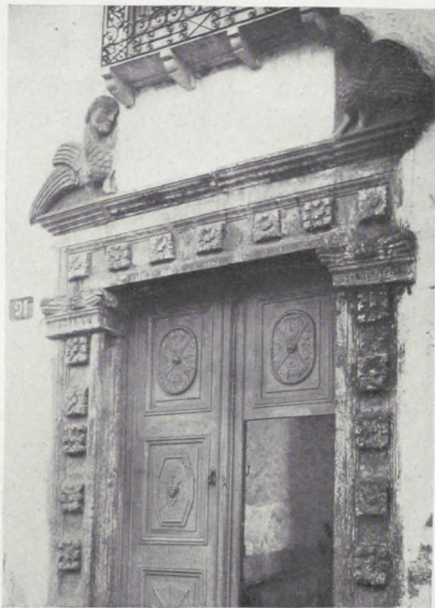
ANCIEN PORTIQUE AYANT APPARTENU A LA MAISON DE GARCILLASSO
