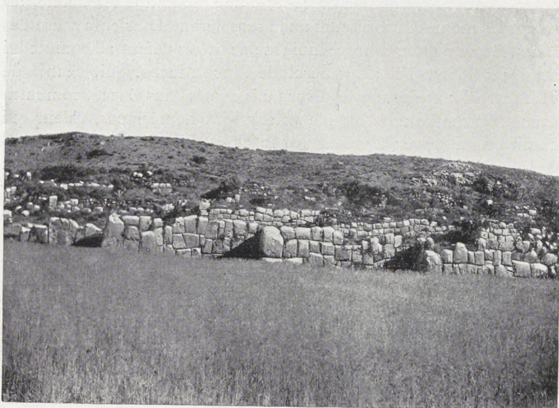
LA MURAILLE DU SACSAYHUAMAN, VUE DU RODADERO
