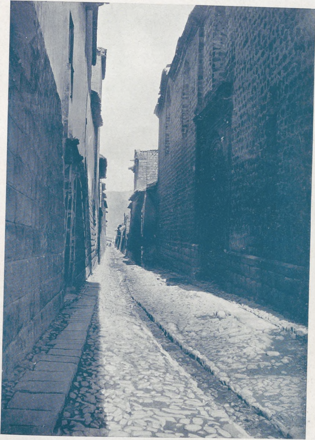
RUE DE L'ANCIEN CUZCO
