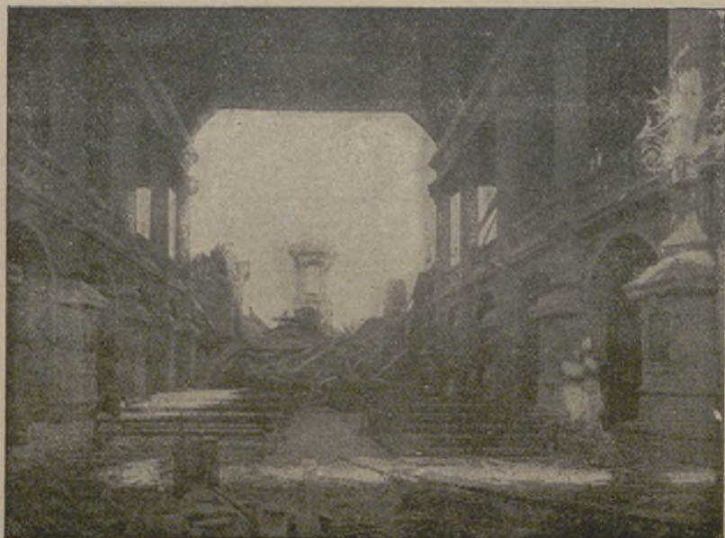
Interior de la iglesia de la Merced, de Valparaíso, después del terremoto del 16 de agosto de 1906.
