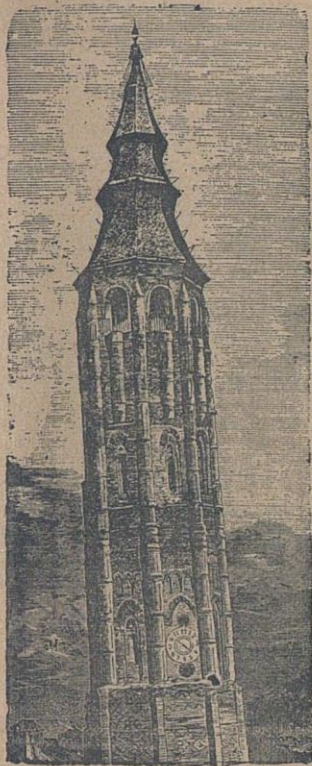
Torre Nueva inclinada.
