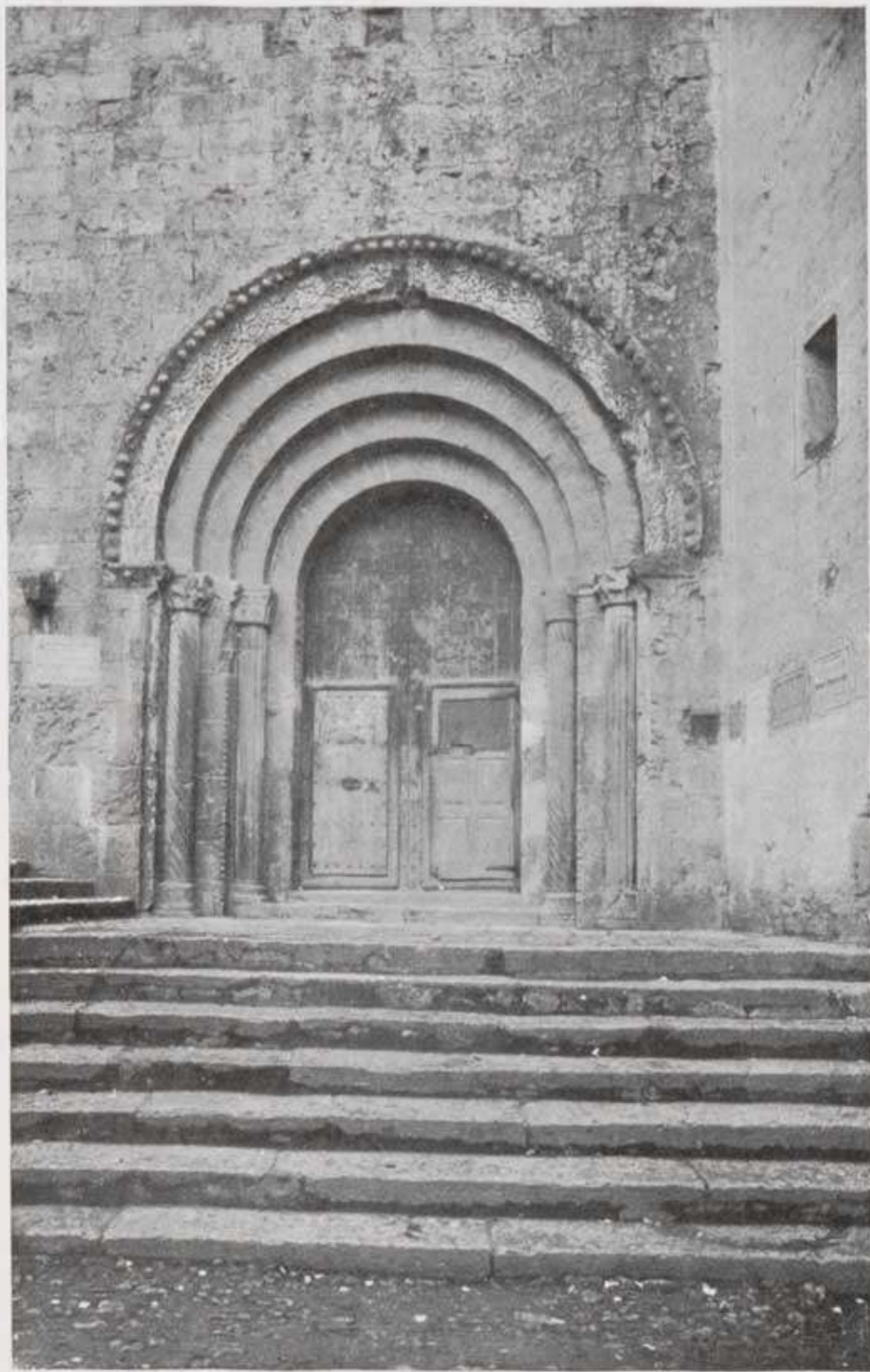
Notable ejemplar del arte románico, con interesantes detalles en las arquivoltas y capiteles que coronan las columnas.
