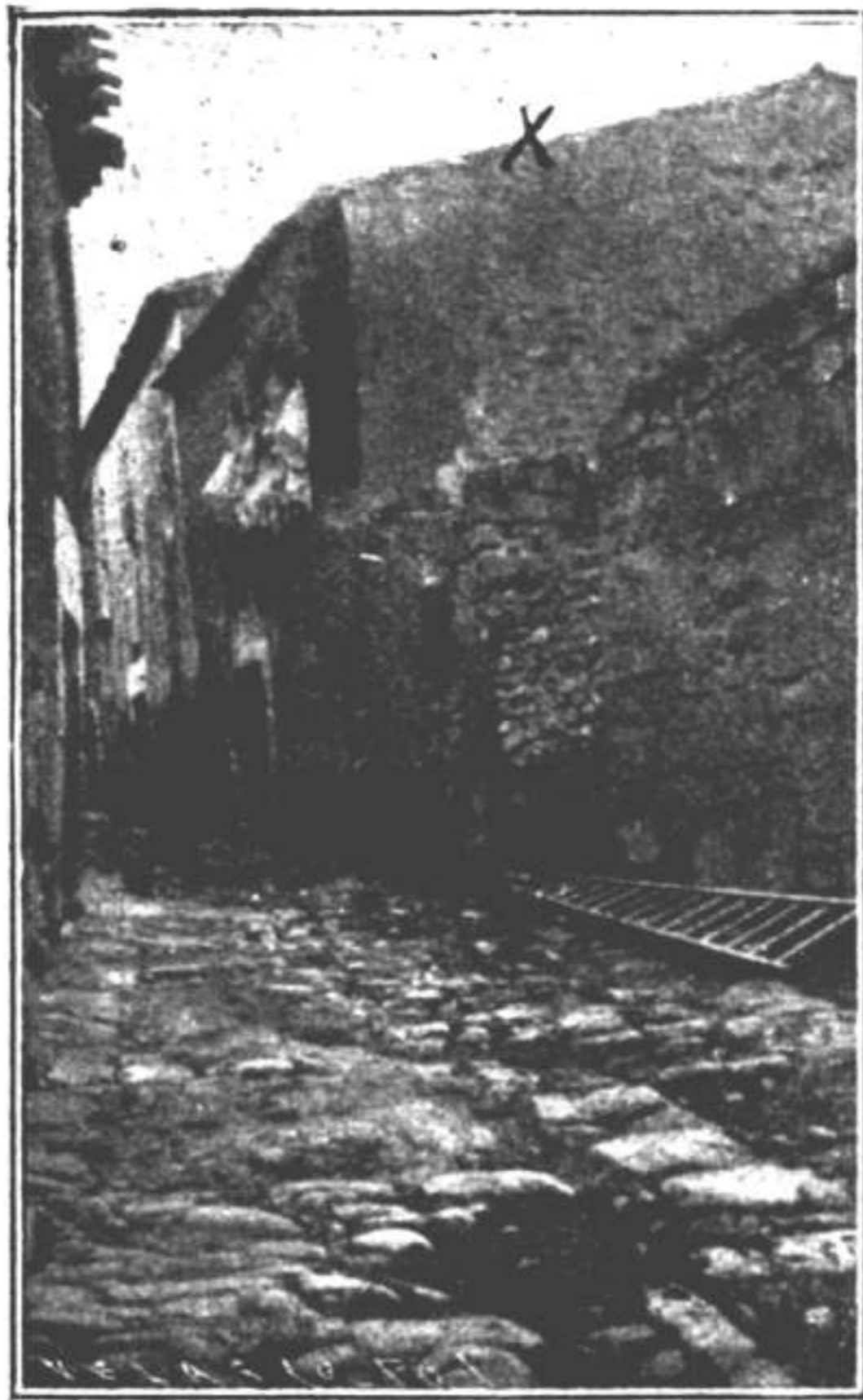
La casa de Joannis, que se dice fué edificada en una noche (Bargota)
