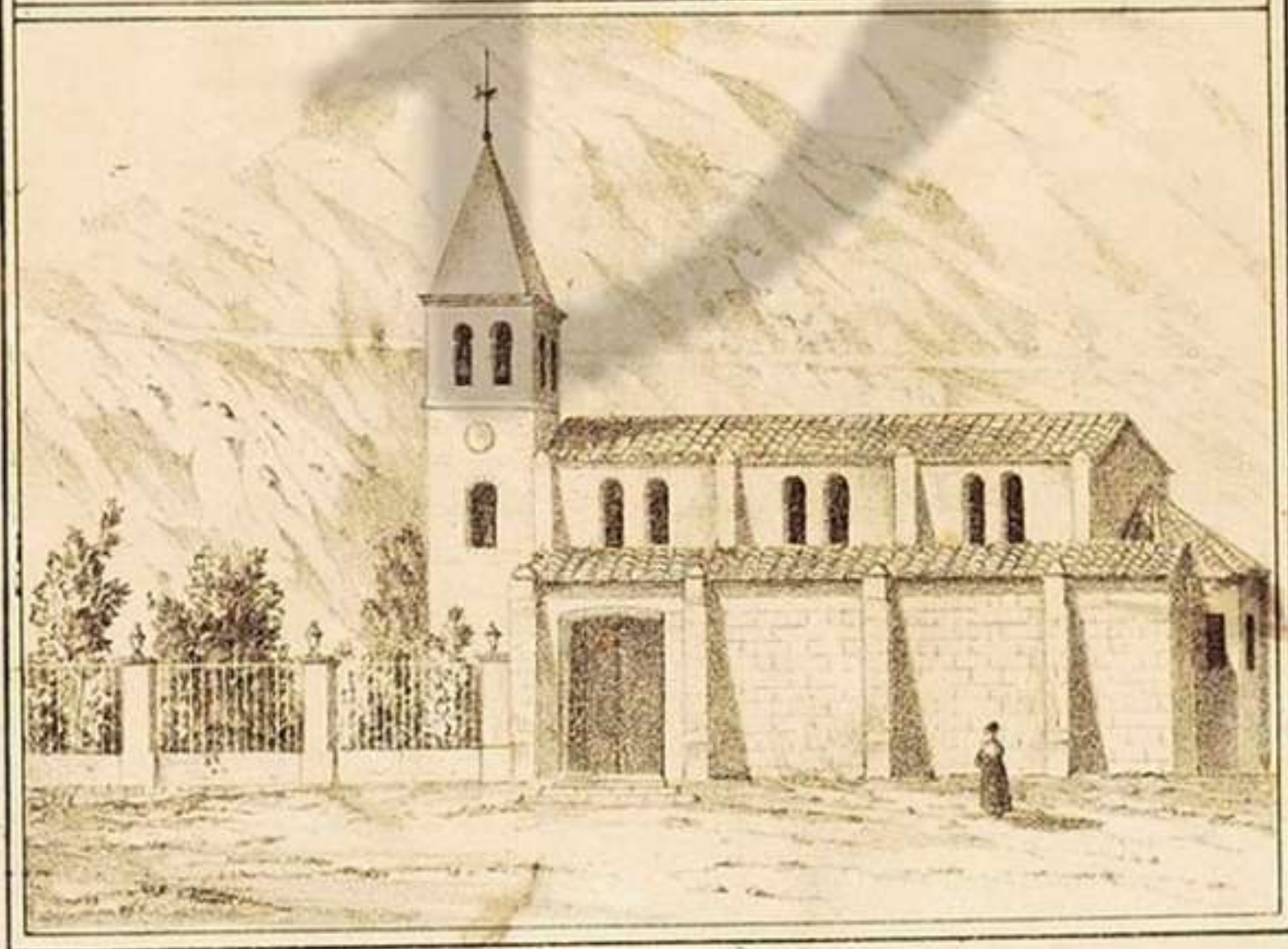
SANTUARIO DE SAN ROQUE (en construcción).
