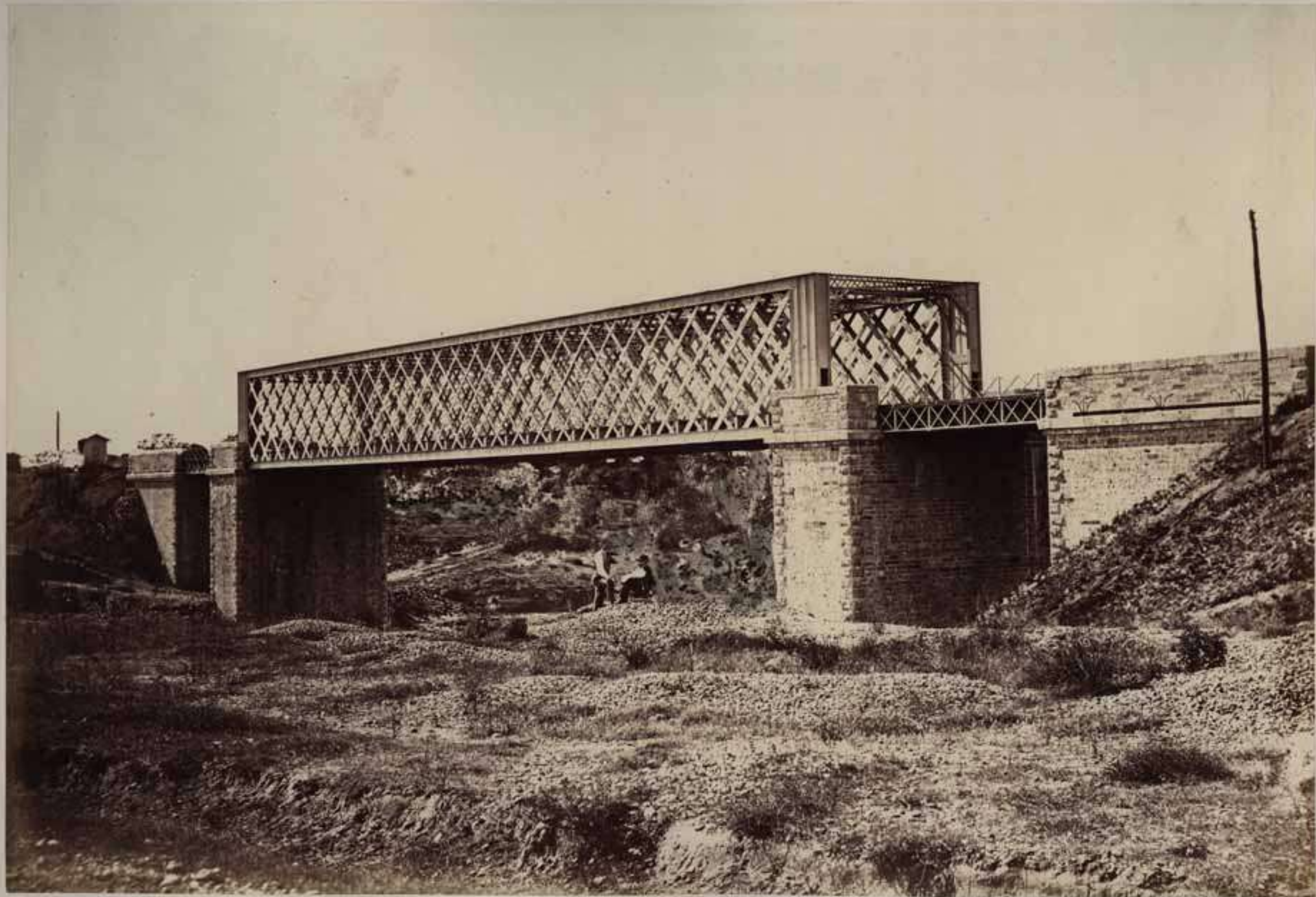
Pont du Oucro. Station de Viana.
