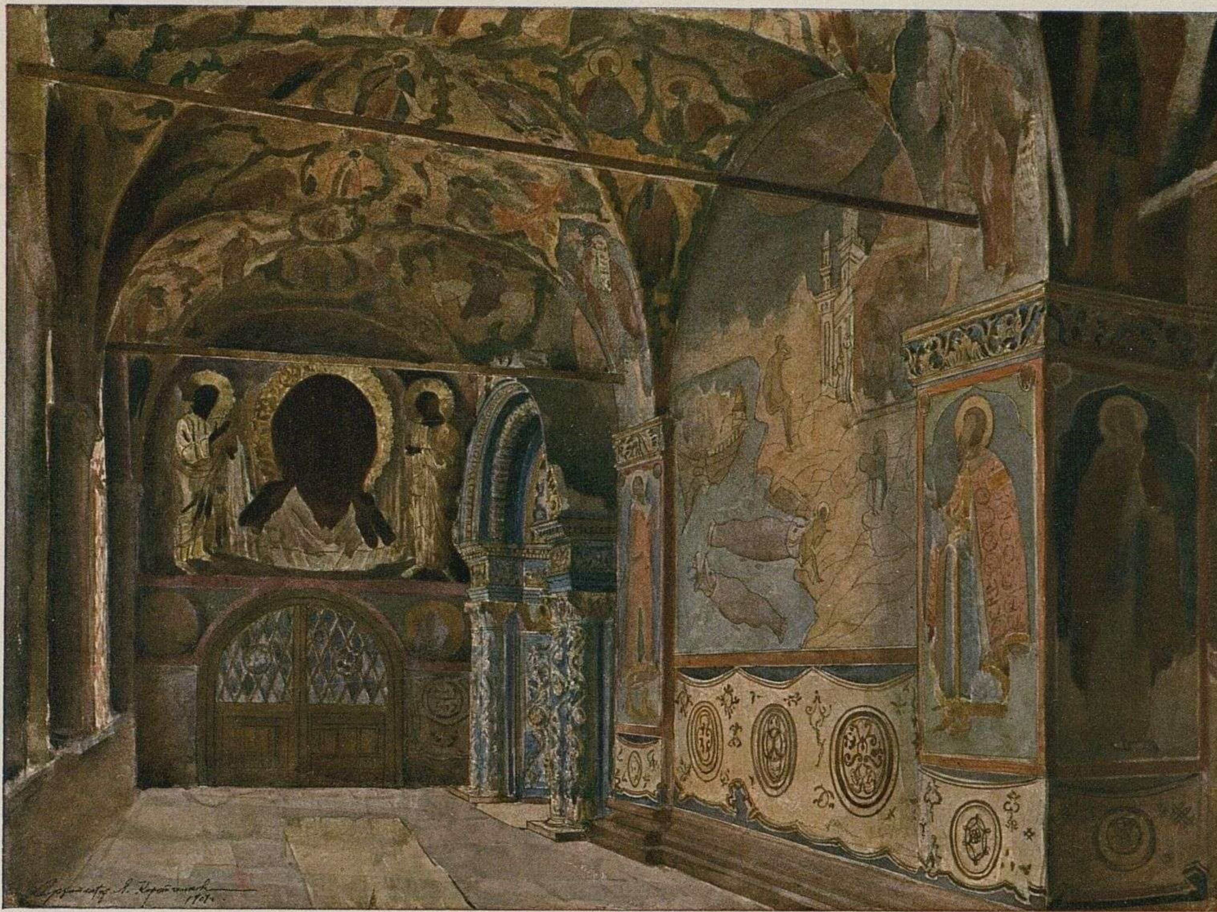
20. Входная сторона сѣверной части галереи Благовѣщенскаго собора.
