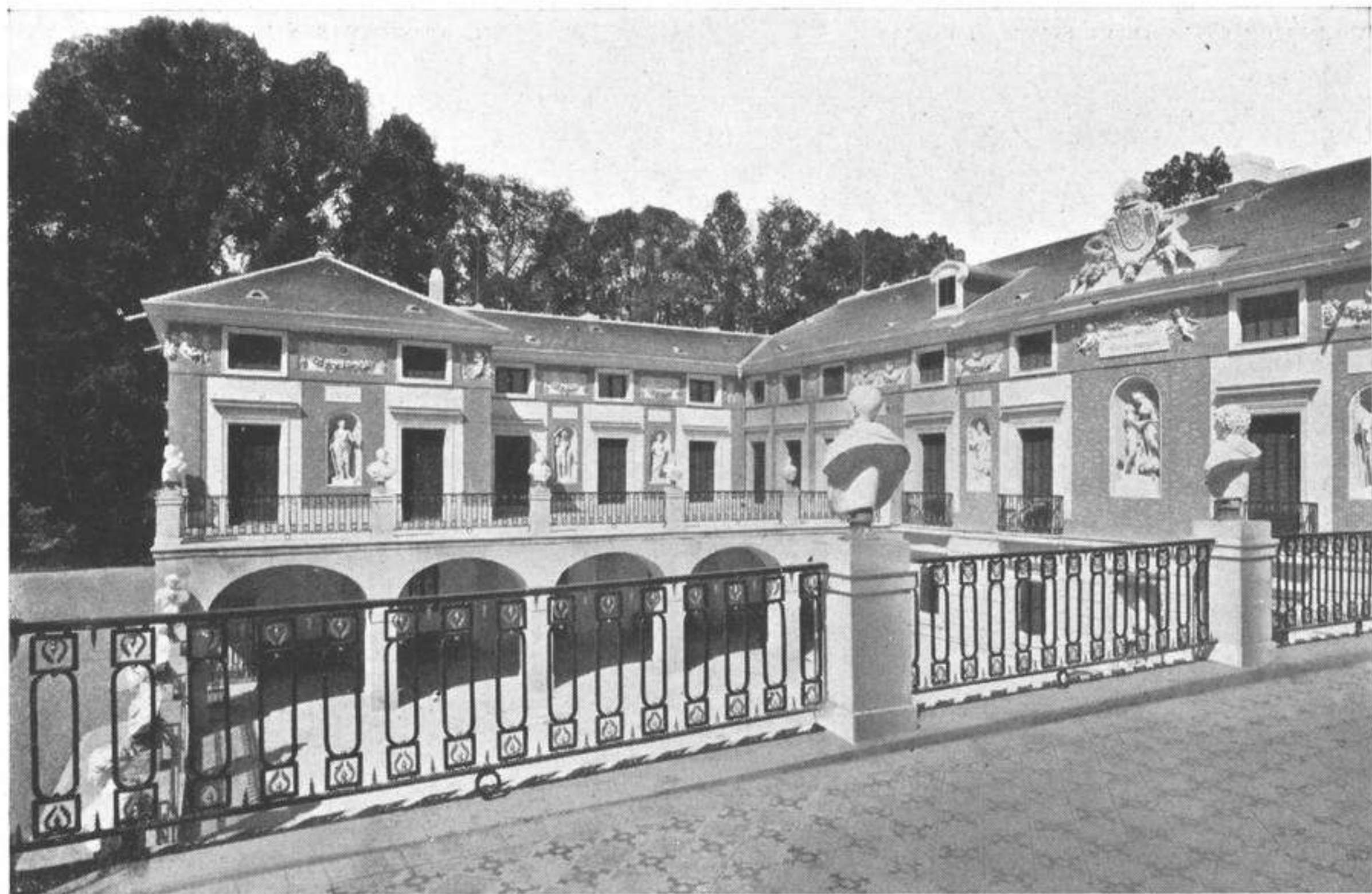
CASA DEL LABRADOR. VISTA DESDE LA TERRAZA
