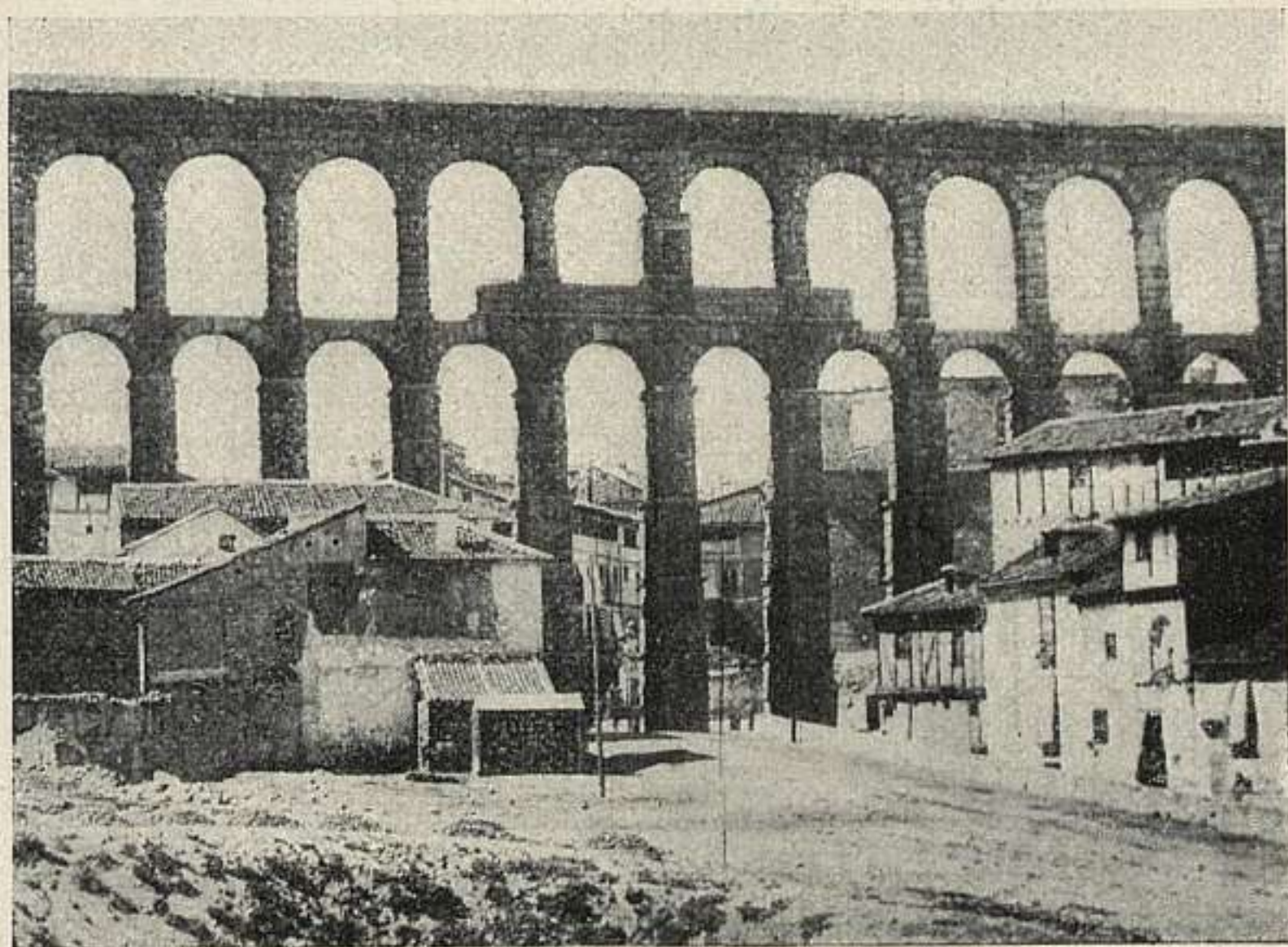
768. SEGOVIA: EL ACUEDUCTO.
