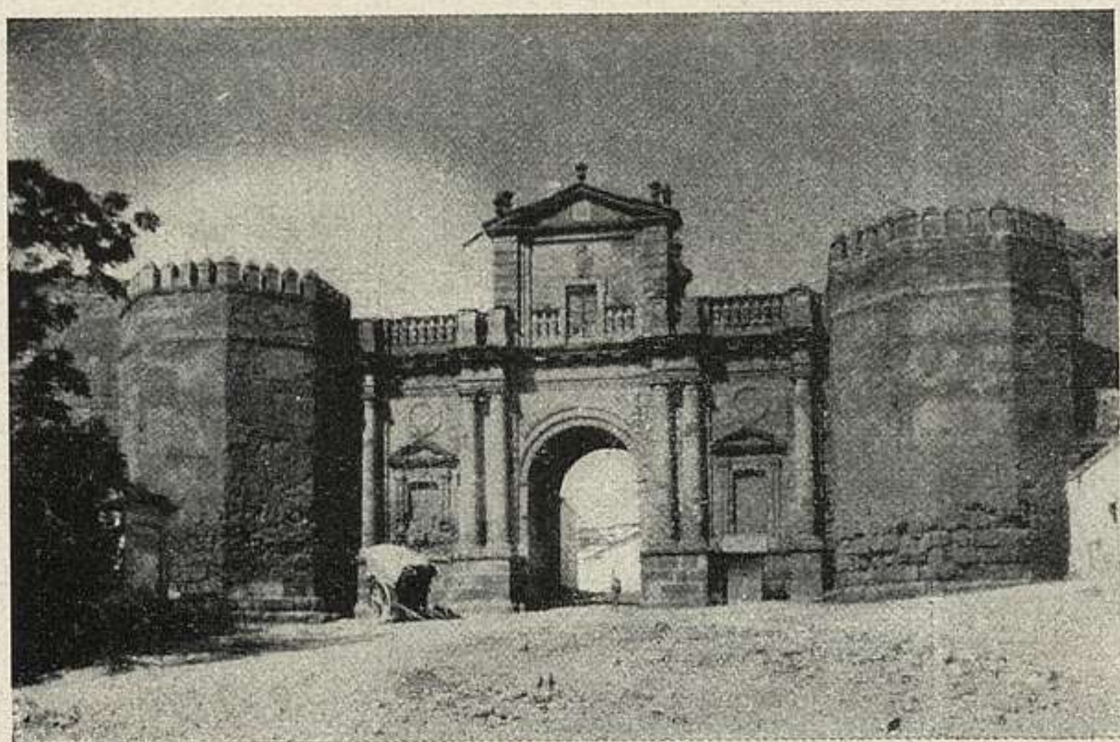
830. CARMONA: PUERTA DE CÓRDOBA.
