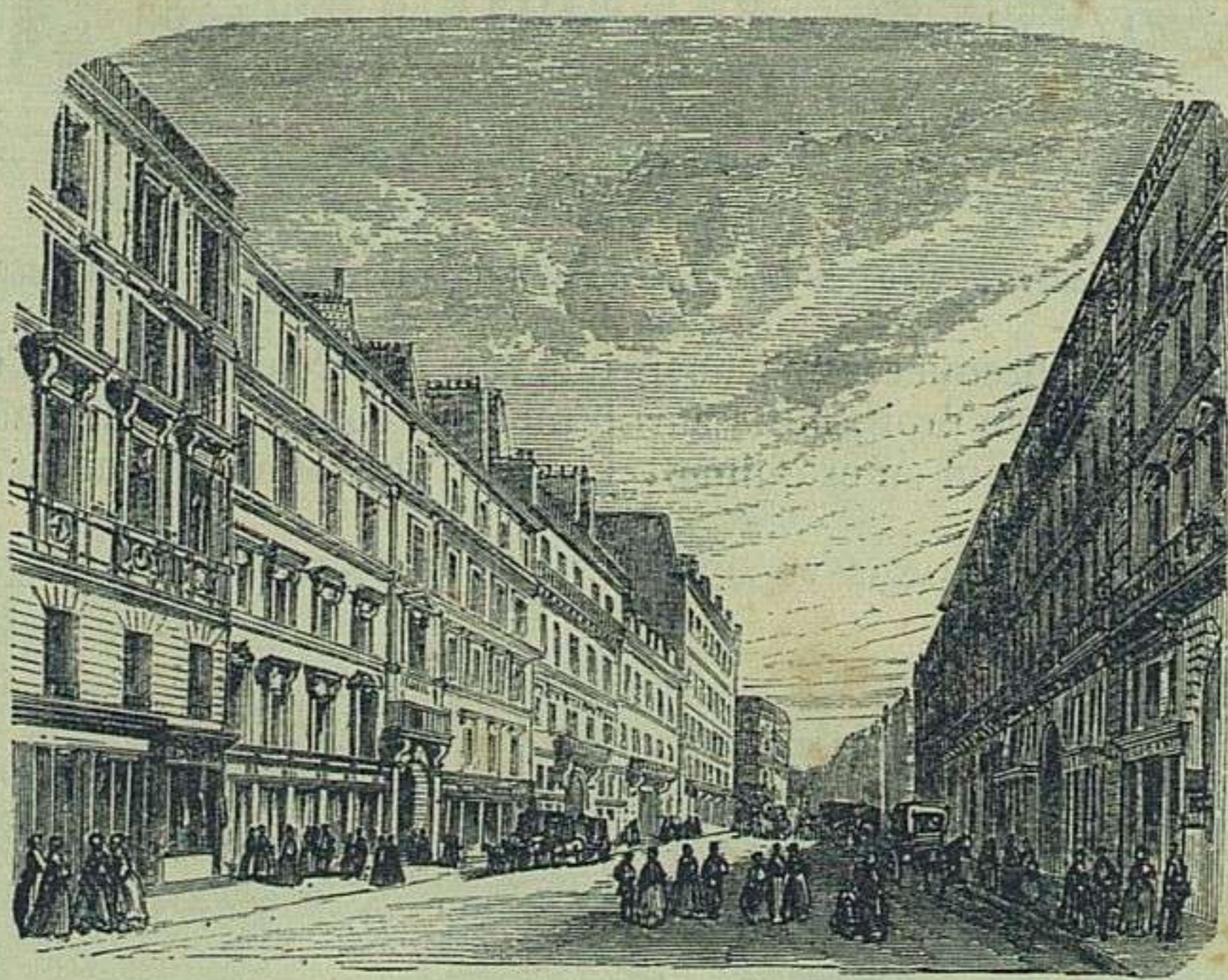
Fig. 73. — Vue fuyante. — Déformation.
