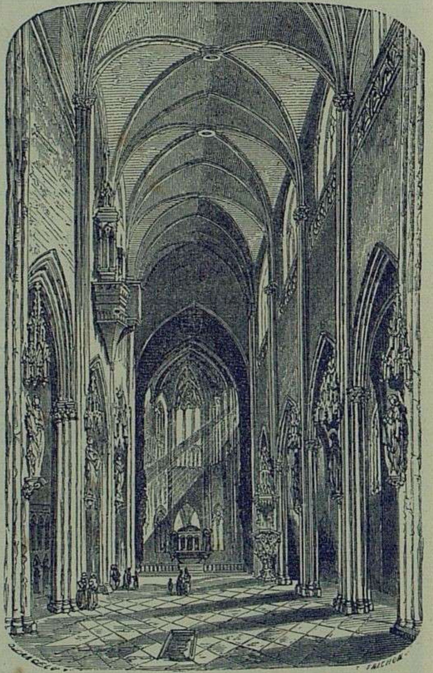
Fig. 145. — Voûtes d'arête. — Application.
