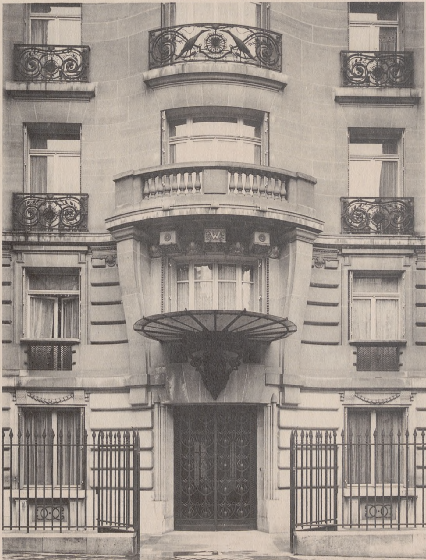
BALCON DU THÉÂTRE DES MATHURINS, A PARIS — M. SICLIS, Architecte-Décorateur. IMMEUBLE, AVENUE MARCEAU. — ENSEMBLE DE LA FERRONNERIE. — M. GRANET, Architecte. — ROBERT, Ferronnier. Ateliers E. BORDEREL et ROBERT.
