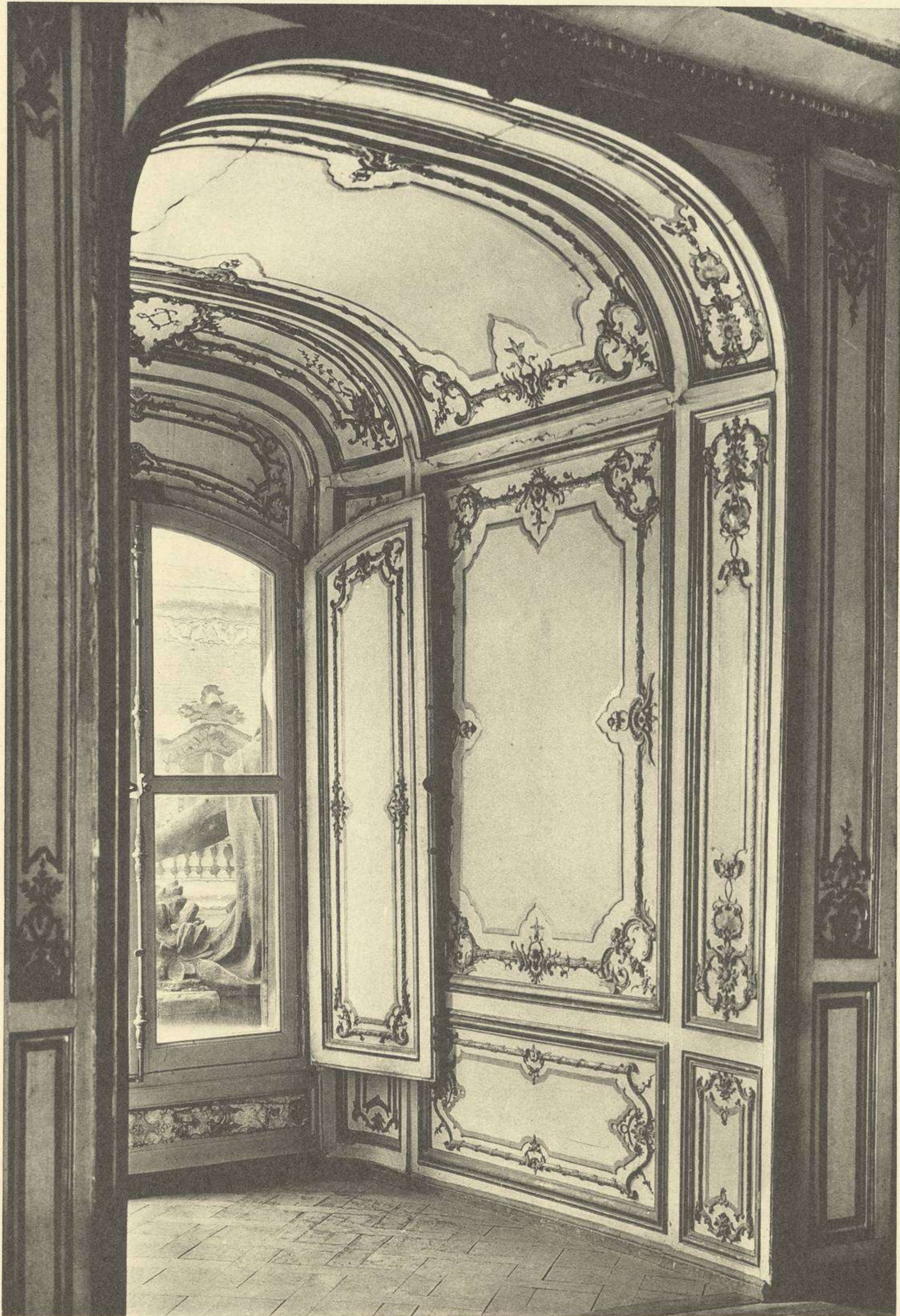
SALON, DÉTAILS DES FENÊTRES
