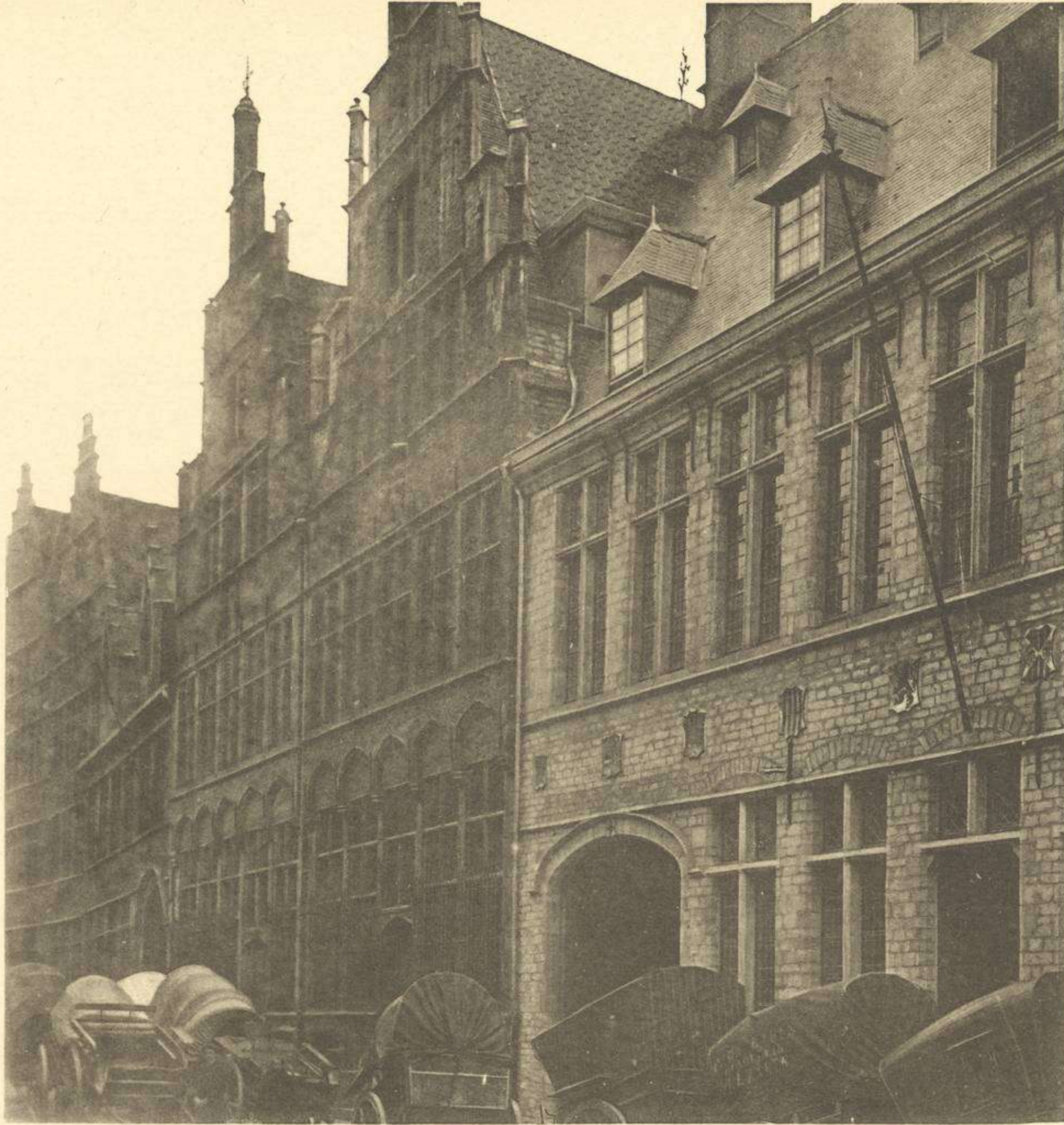
Façades de la rue Haut-Port à Gand. La cour Saint-Georges (ancienne gilde de tireurs à l'arbalète).
