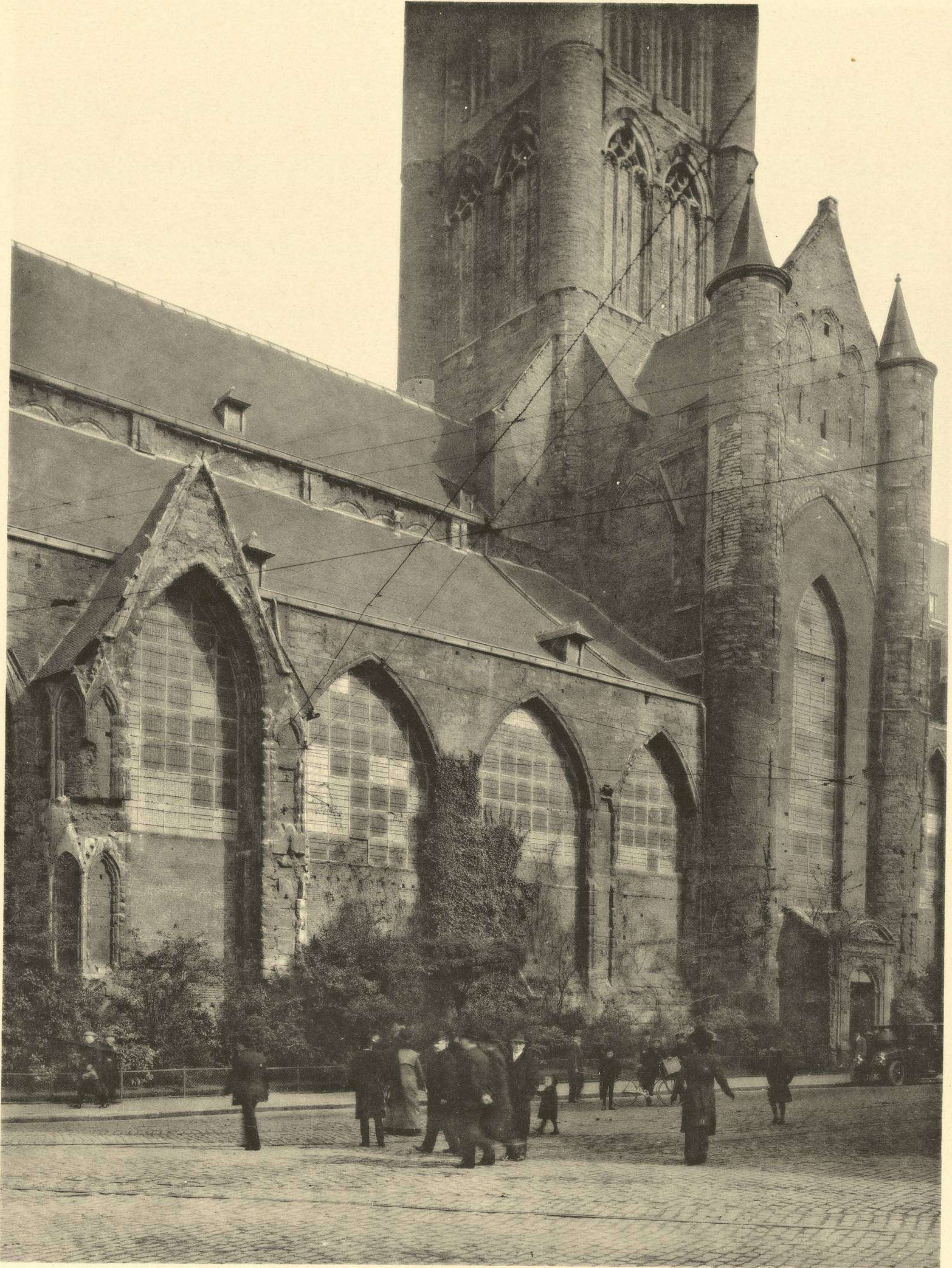
La façade latérale de l'église Saint-Nicolas, vue de la rue de la Catalogne.
