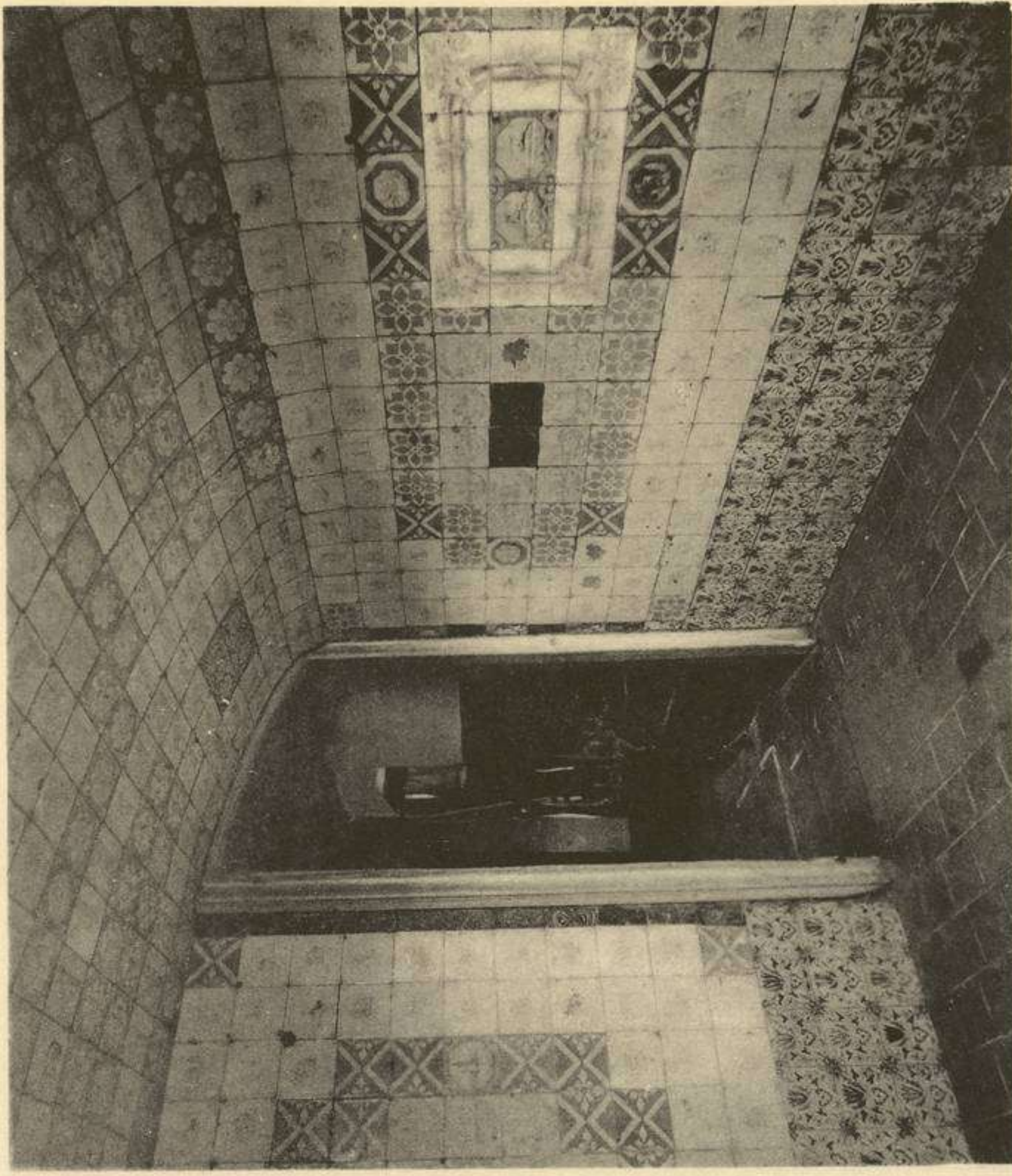
Voûte et parois, en face de la cheminée, (voir à gauche) avec d'intéressants motifs de décoration polychrome.
