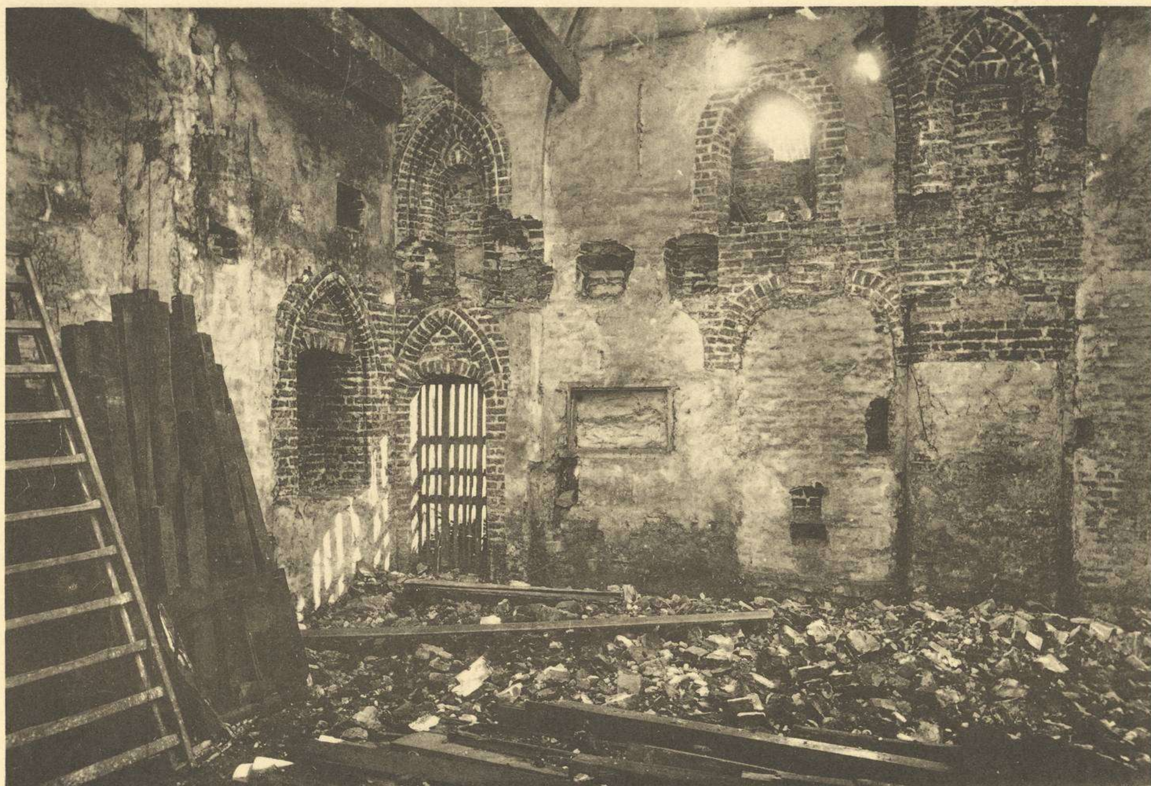
Etat au moment de la démolition récente, à hauteur des fenêtres, sur les murs, se trouvaient les célèbres peintures murales si discutées.
