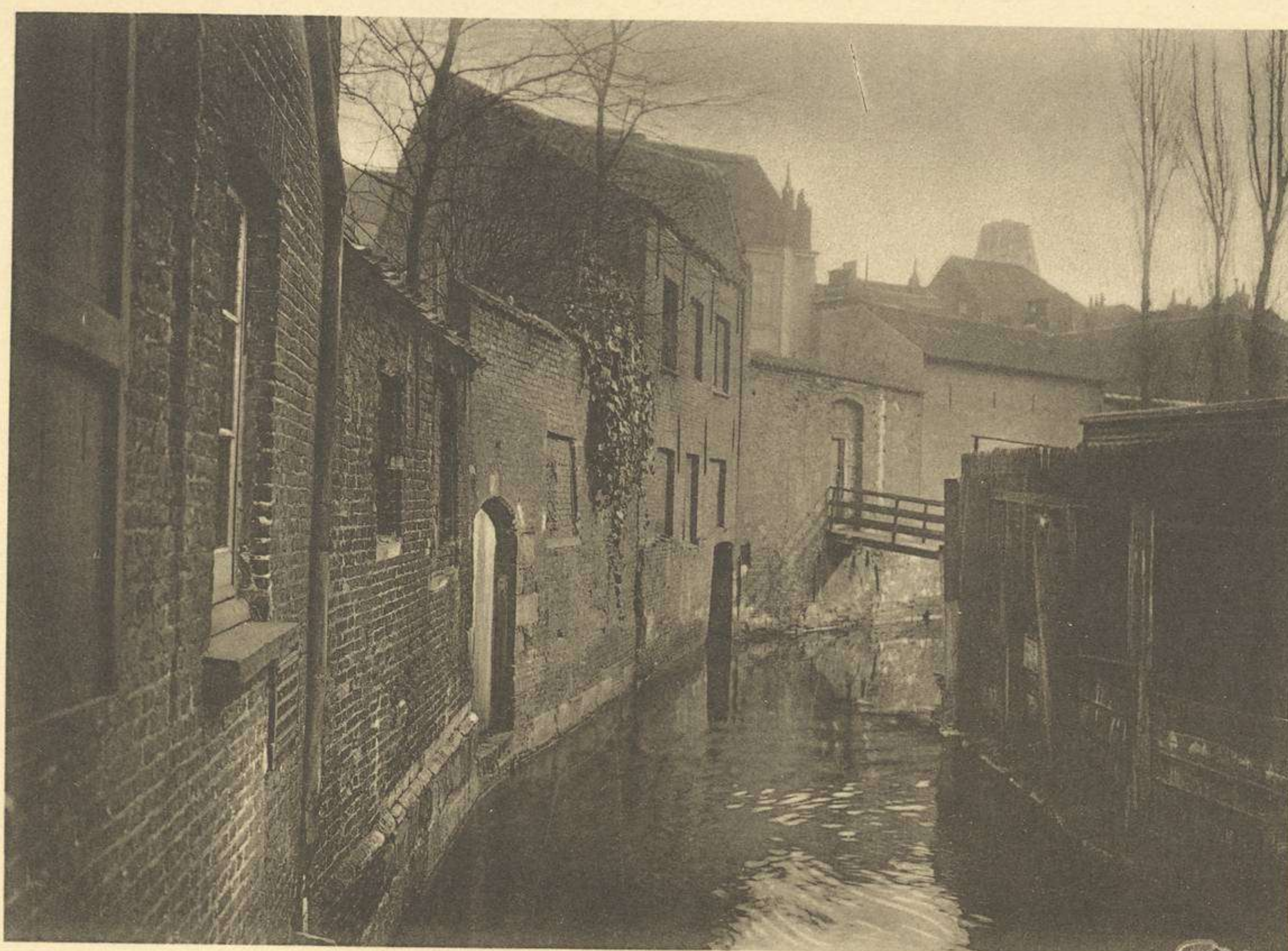
Une partie de son cours encore visible près du Petit Béguinage.
