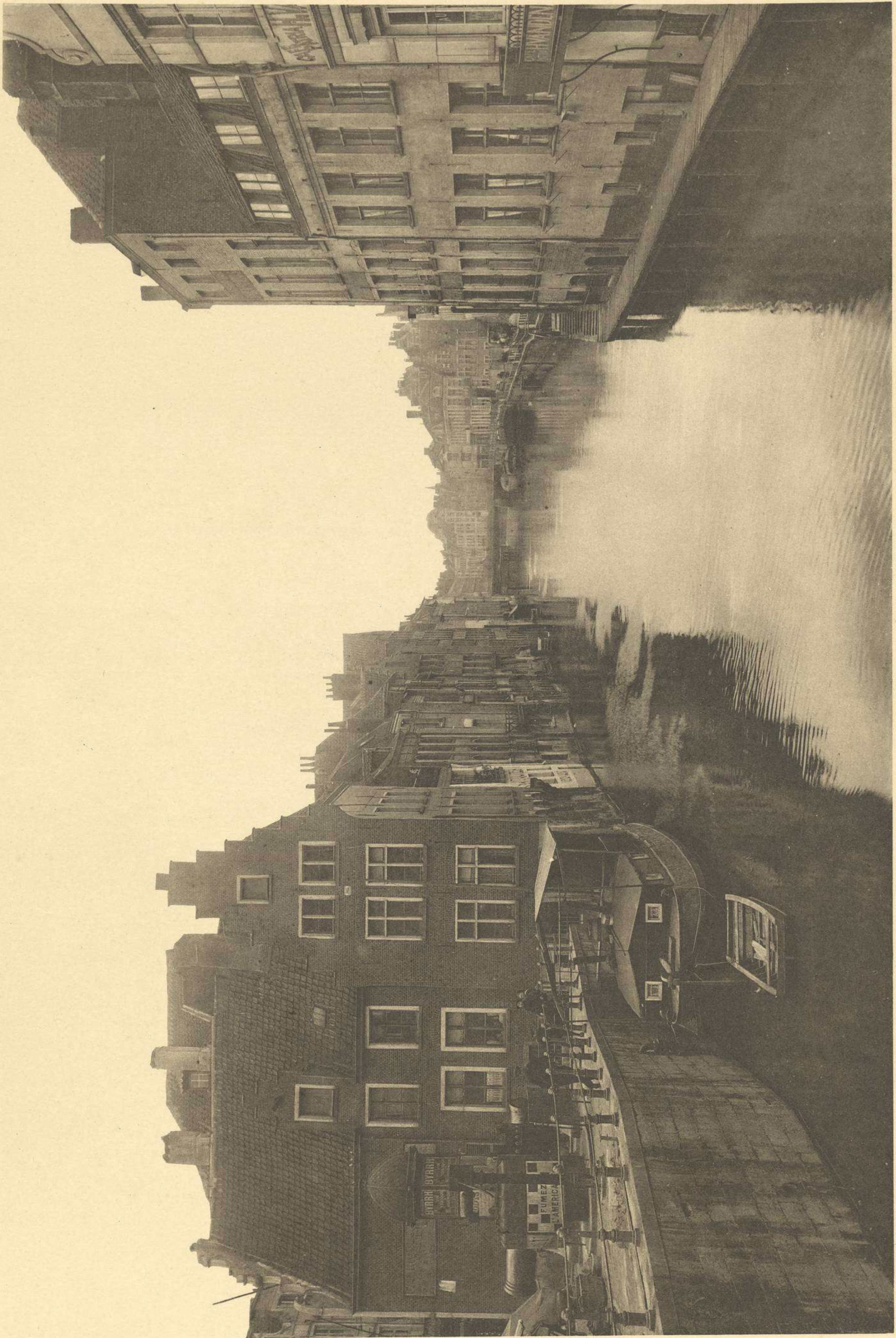
Le quai de la Grue. Vue sur la Lys (au fond le pont de la Boucherie).
