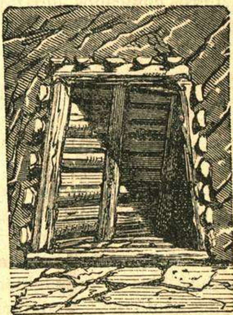
Fig. 5.ª—Entibación de una mina mediante maderaje.
