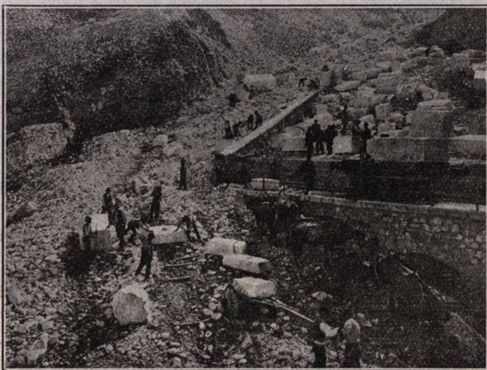
Fig. 225.—Arrastre y carga de sillares en las canteras de Carrara (Italia). (Fotografía comunicada por el Marqués de Maccarani).
