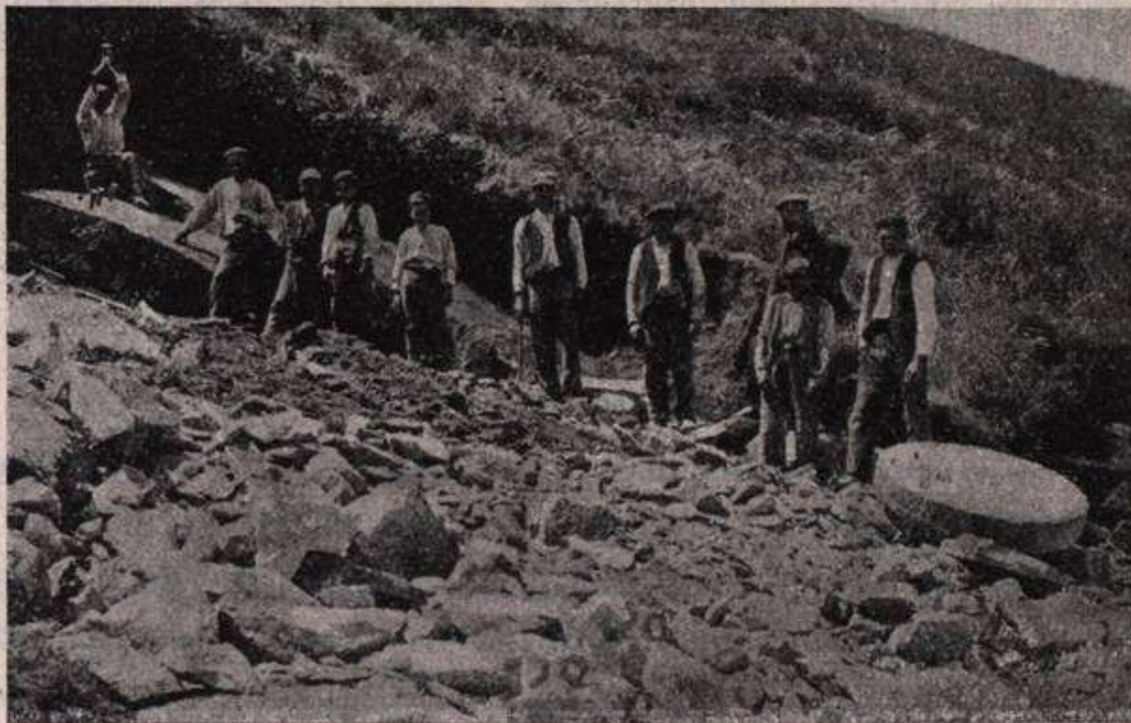
Fig. 367.—Cantera de arenisca en Cabezón de la Sal (Santander): hendiendo la roca con cuñas. (Fot. O. Cendrero).
