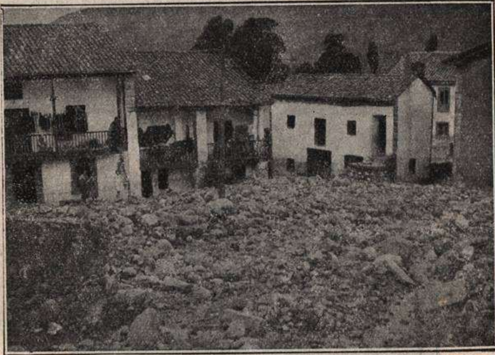
Fig. 292.—En Ontaneda, San Vicente de Toranzo, etc. (Santander) el 4 julio 1931 varios torrentes destruyeron casas, etc. por la enorme cantidad de piedras que arrastraron, según puede apreciarse en la figura. (Fot. O. Cendrero).
