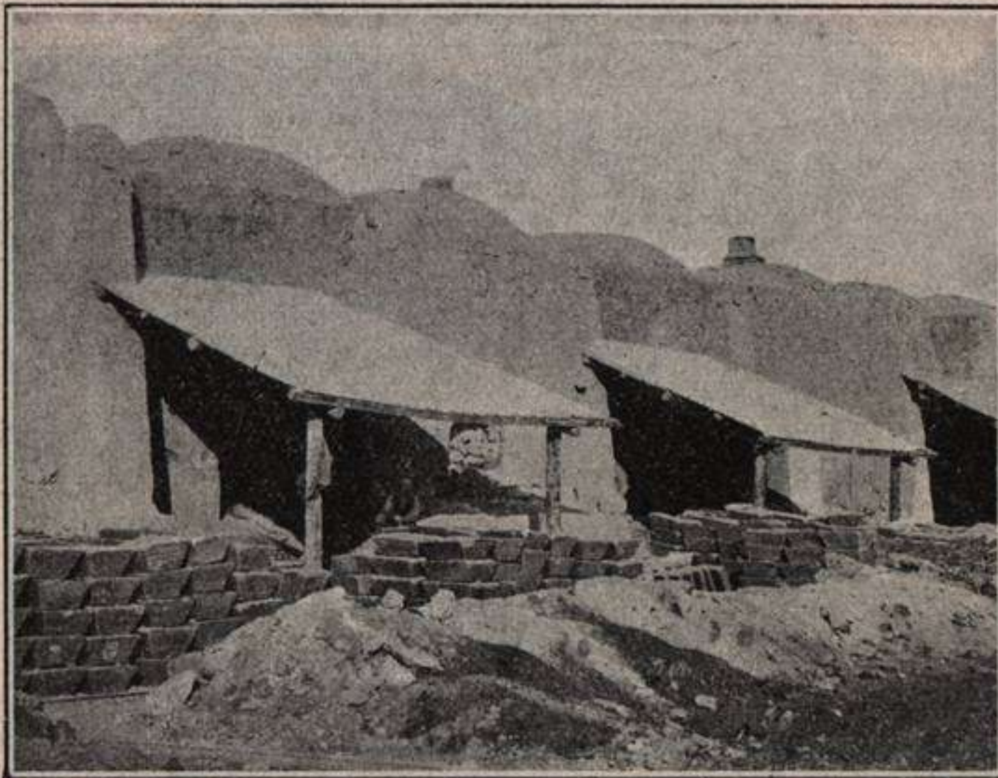
Fig. 194.—Minas de azufre de Libros (Teruel).—Hornos de primera fusión, delante de los cuales se ve el azufre moldeado en pastillas de 60 kilogramos cada una. (Fot. com. por el Dr. J. Pueyo Ledesma).
