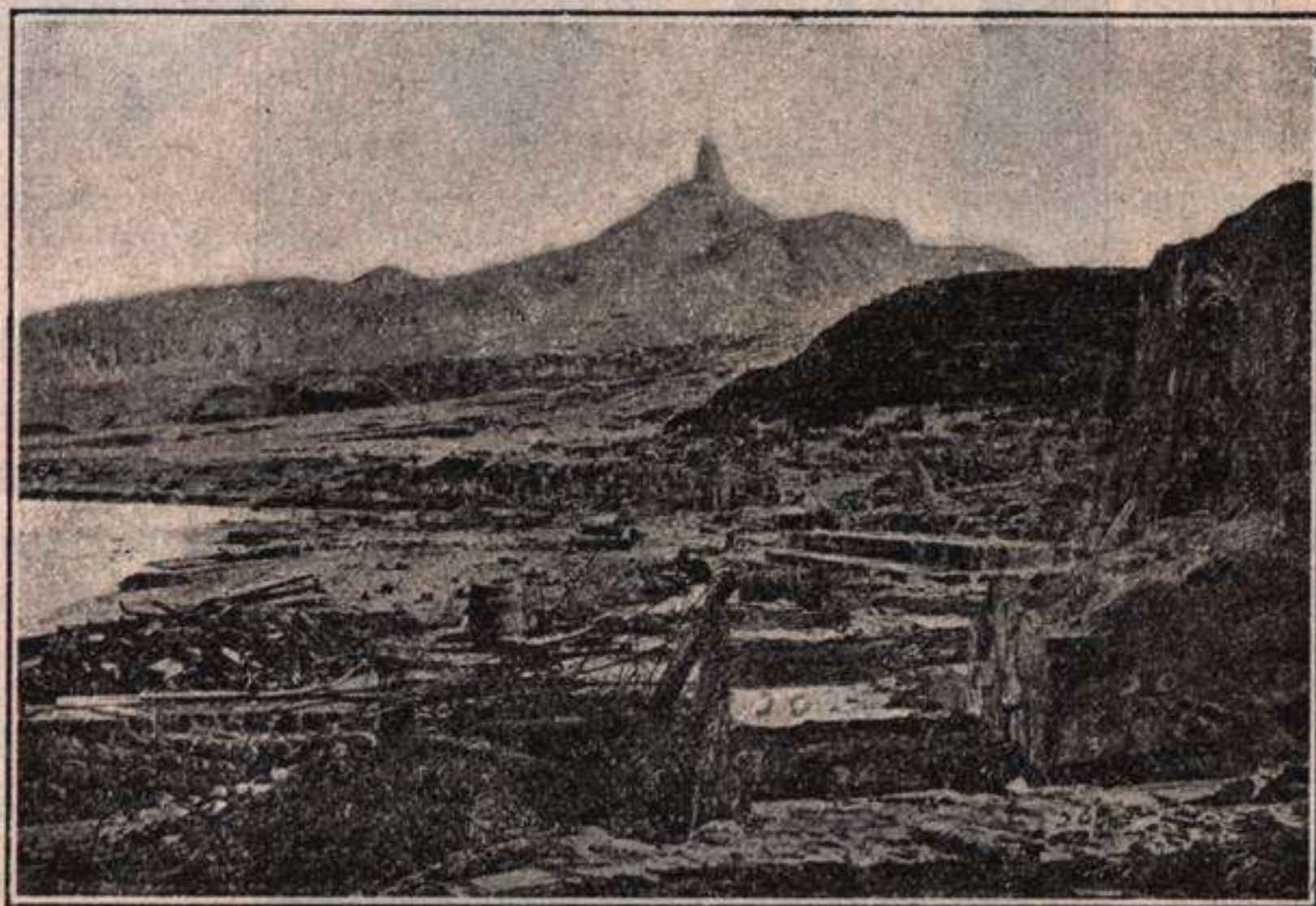
Fig. 410.—Vista parcial de la ciudad de San Pedro de la Martinica después de su destrucción por la nube de la figura 409: al fondo la Montaña Pelada con una aguja sólida que emergió por el cráter después de la erupción. (Fot. Lacroix).
