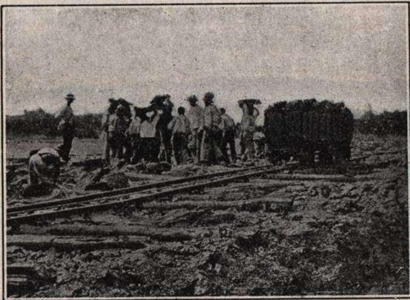
Fig. 251.—Extrayendo bloques del lago de asfalto de la fig. 250. (Fot. com. por el profesor venezolano Dr. Eladio A. del Castillo).
