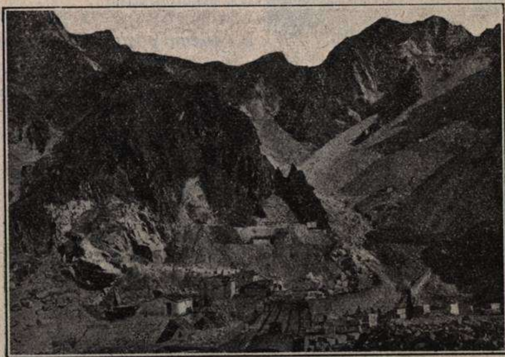
Fig. 223.—Vista parcial de las célebres canteras de mármol de Carrara (Italia). (Fot. com. por el Marqués de Maccarani).
