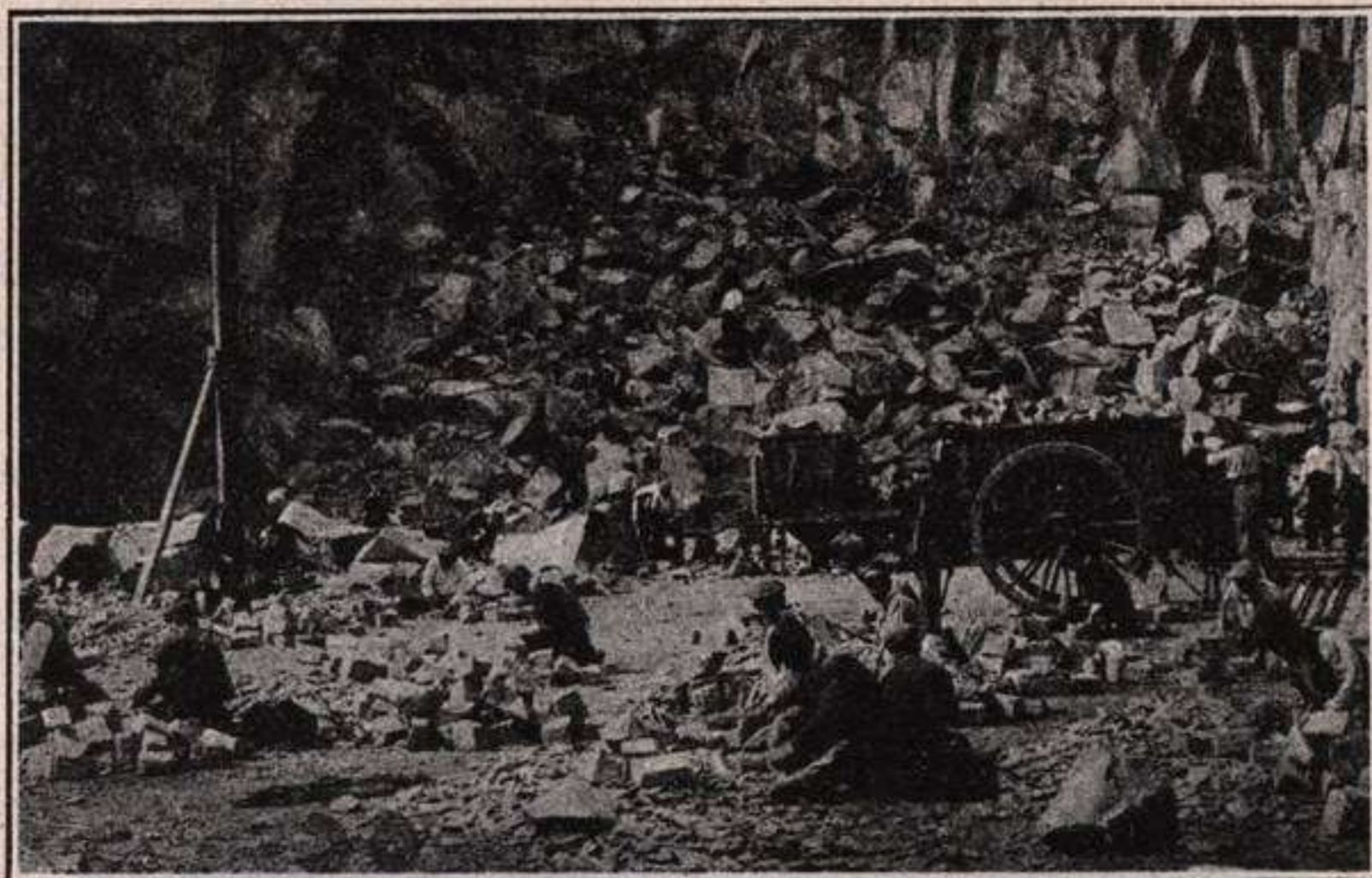
Fig. 431.—Elaboración de adoquines en la cantera de la figura 429. (Fot. com. por el prof. Dr. M. San Miguel de la Cámara).
