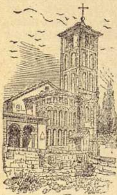
Fig. 208.—Iglesia y torre de Sta. M. a de Cuéllar.
