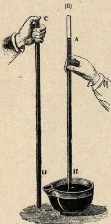
Construcción del barómetro
