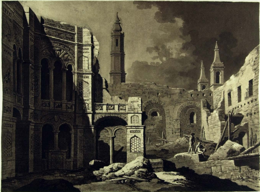
RUINAS DEL PATIO, Y COSTADO DE LA YGLESLIA DE S. TA ENGRACIA.
