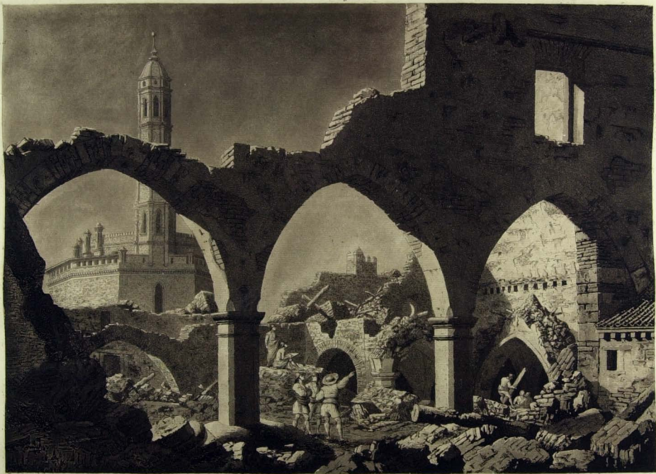
RUINAS DEL PATIO DEL HOSPITAL GENERAL DE N. S. DE GRACIA.
