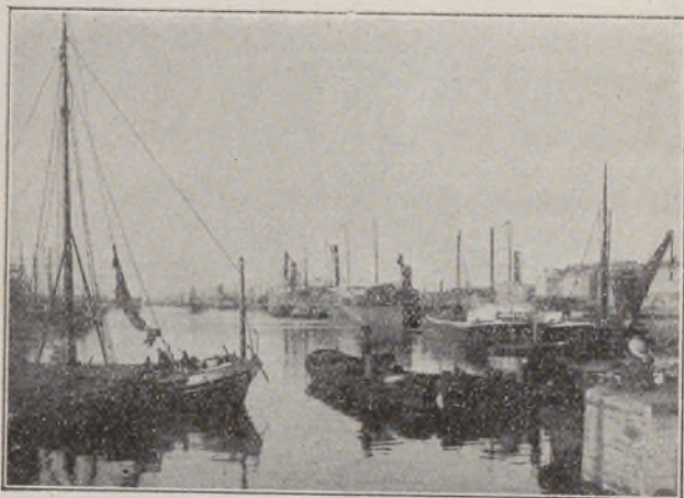
Fig. 92. — Bassin Kattendyk à Anvers.
