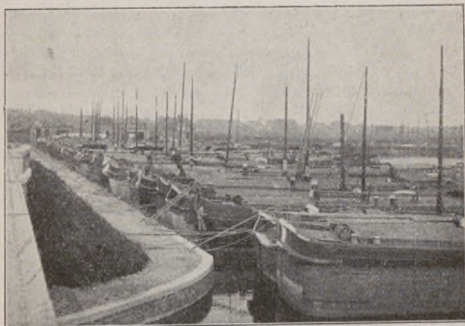
Fig. 120. — Béthune. — La gare d'eau.
