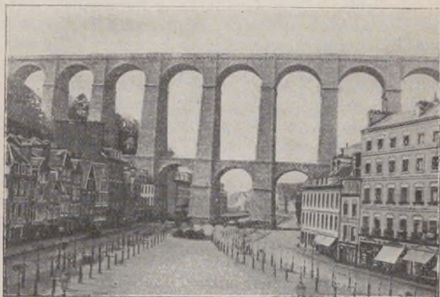
Fig. 155. — Le viaduc de Morlaix.
