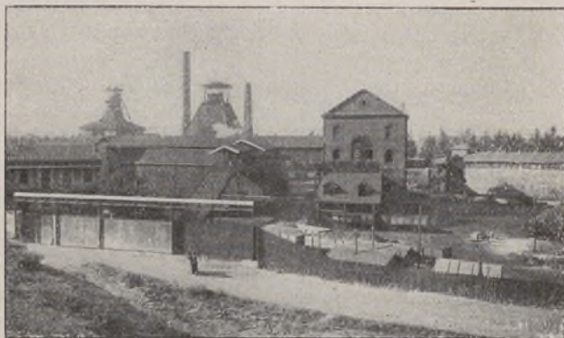
Fig. 167. — Saint-Étienne. — Puits du treuil.
