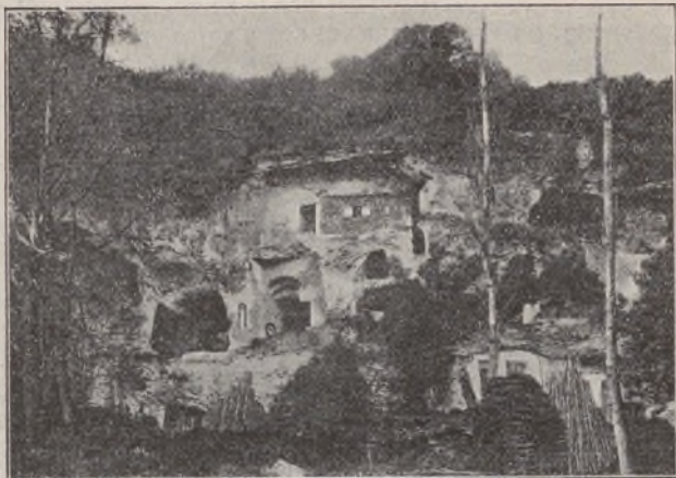
Fig. 27. — Habitations creusées dans la craie de l'Eure-et-Loir.
