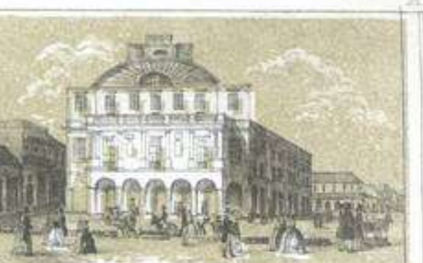
TEATRO PRINCIPAL, construido por el Barón de O'Donnell en 1846
