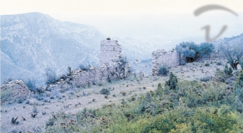
Foto 22. Detalle de una de sus posibles entradas.
