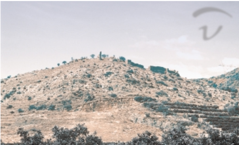
Foto 45. Panorámica general de una parte de sus lienzos y torres circulares.
