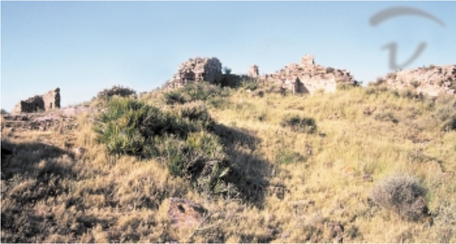
Foto 42. Estado ruinoso de lo que fueron las construcciones más importantes de su interior.
