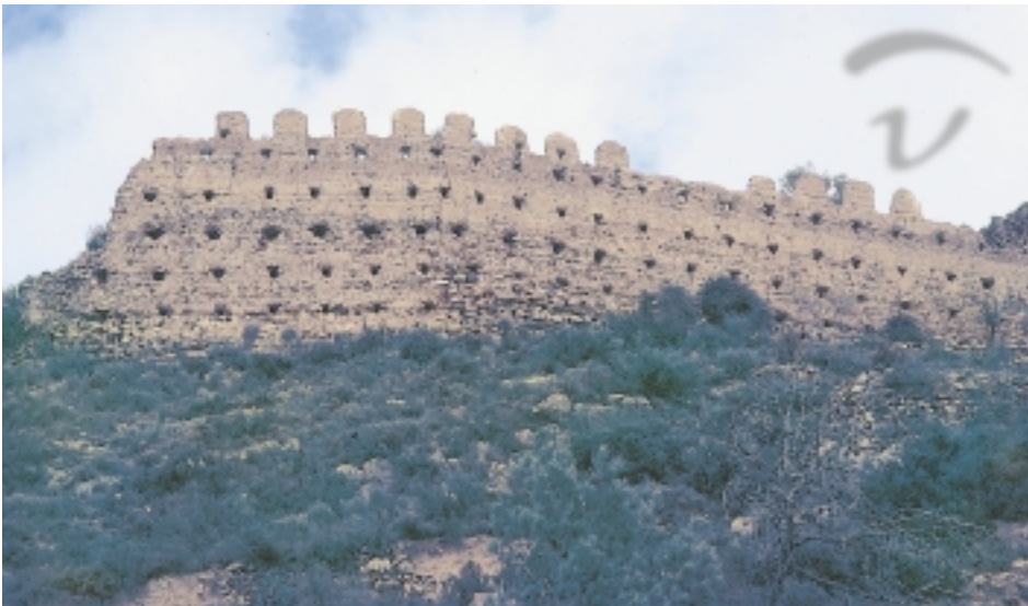
Foto 34. Detalle del recinto amurallado con su antigua altura. Se aprecian los agujeros de los maderos de los encofrados.
