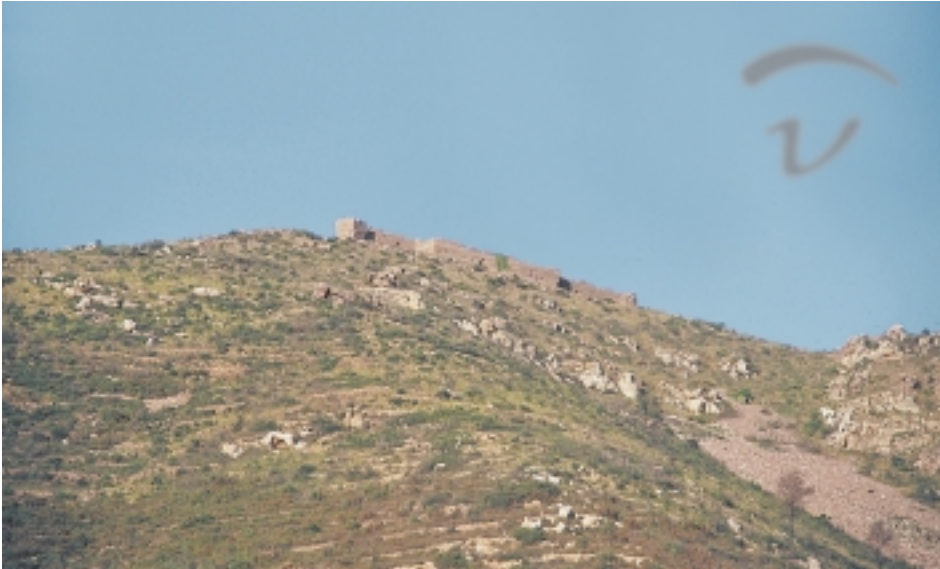
Foto 40. Vista general de parte de su muralla.
