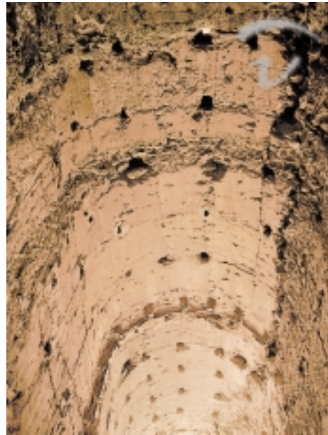
Foto 36. Aspecto de su interior y marcas de sus distintas plantas.
