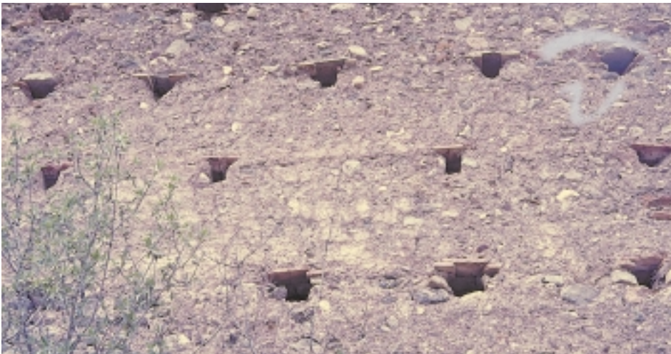
Foto 37. El tapial se realizó colocando piedras y ladrillos en torno a los travesaños de madera con la finalidad de extraerlas posteriormente.
