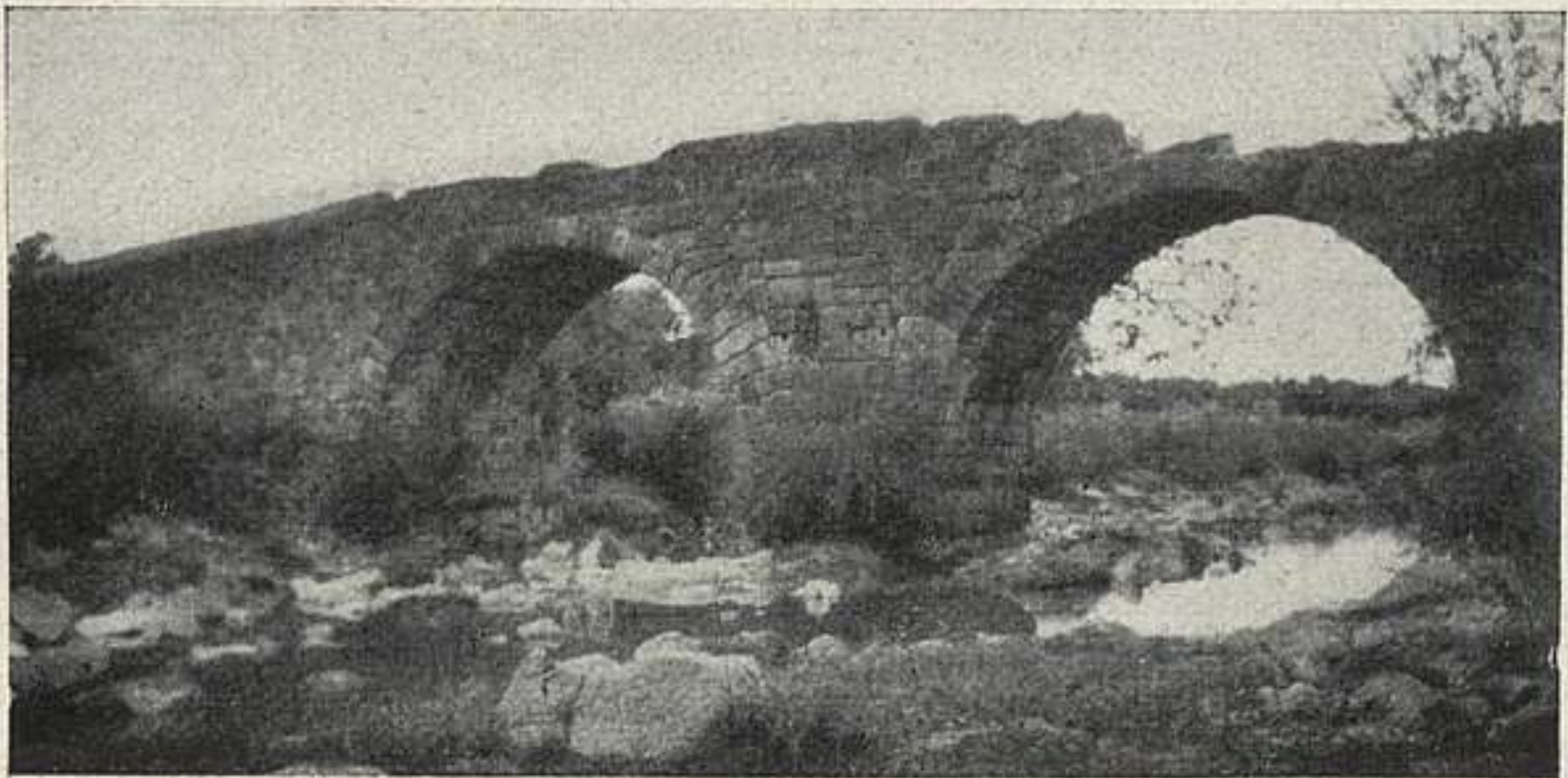
186 a. CÁPARRA: PUENTE.
