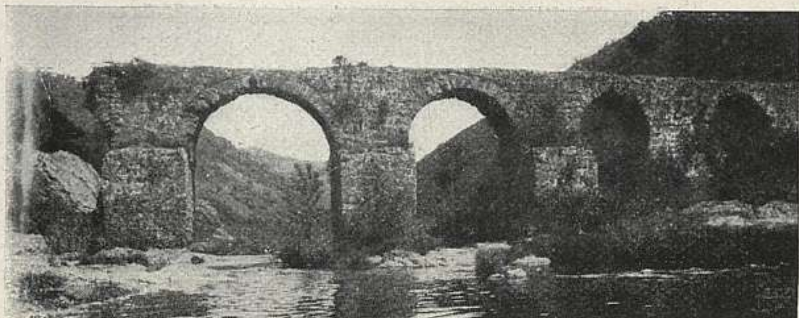
261. PUENTE DEL GUADIATO.
