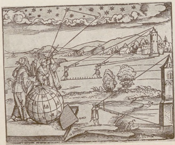
Observaciones con el báculo de Jacob Xilografía de la Introductio Geographica de Apianus (1533)
