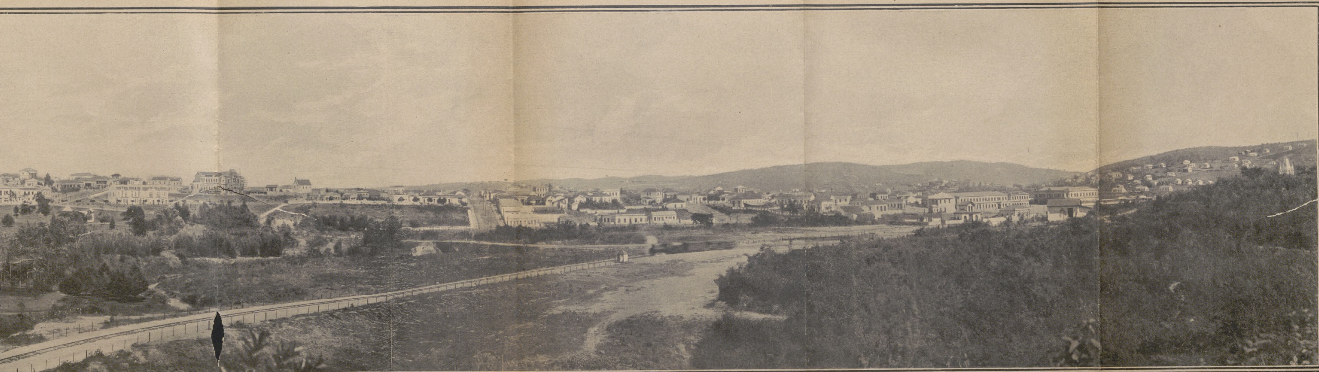
AD DE BELLO HORIZONTE, EDIFICADA EN CATORCE AÑOS, PARA CAPITAL DEL ESTADO DE MINAS GERAES
