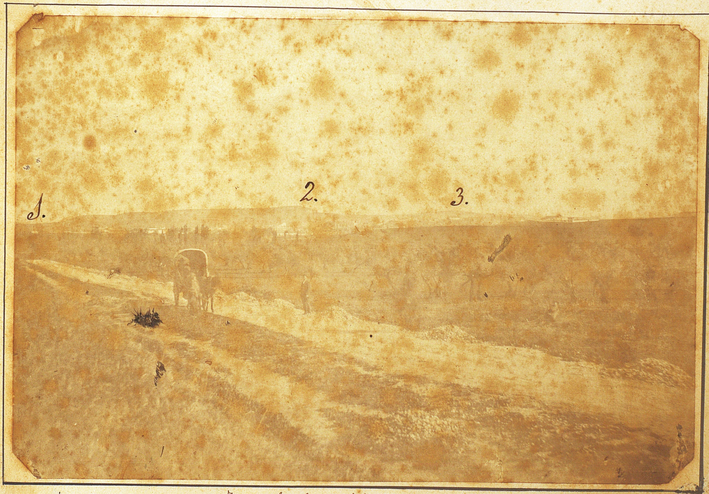
VISTA GENERAL BAILEN. Tomada desde el lado del Mediodia ó Barretera de Jaén.
