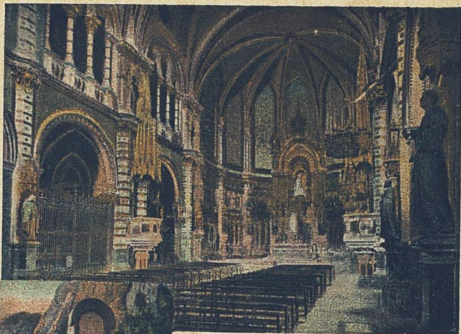
INTERIOR DE LA IGLESIA
