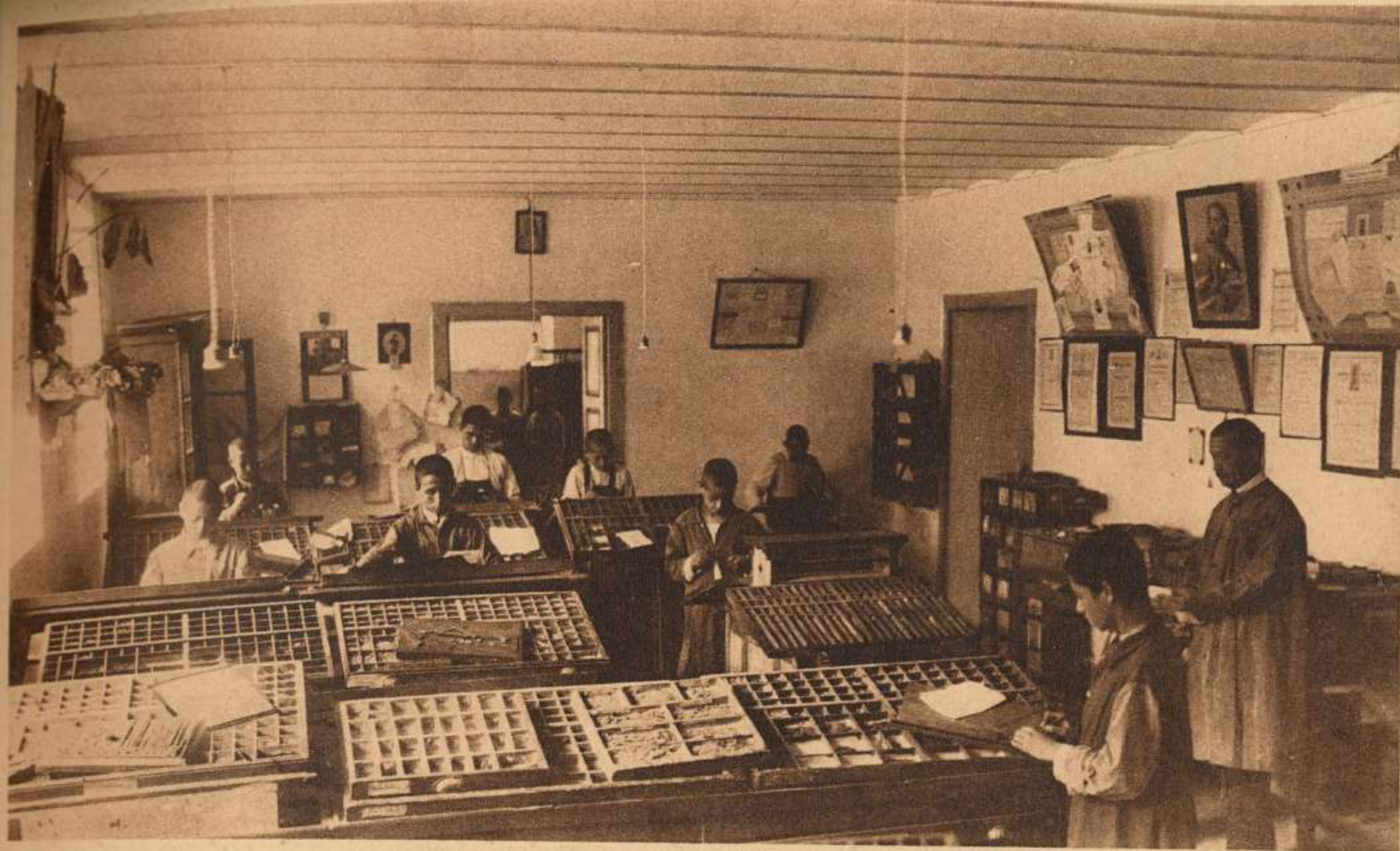
Escuela de tipografía (Sección de cajas)
