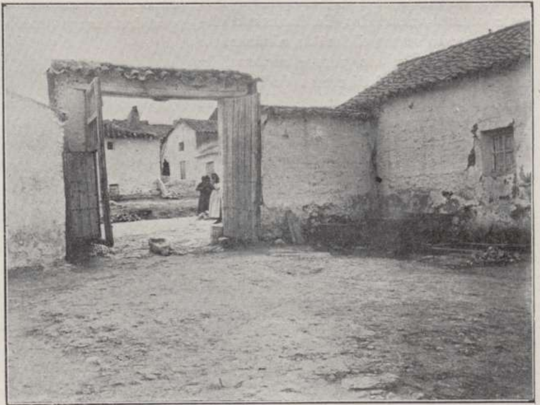
UNA VENTA DE LA MANCHA DEL NATURAL
