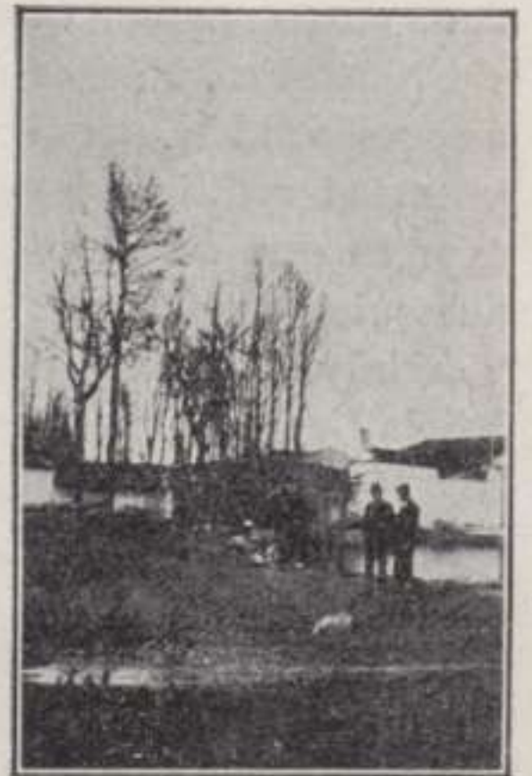
ARGAMASILLA DE ALBA PUENTE VIEJO
