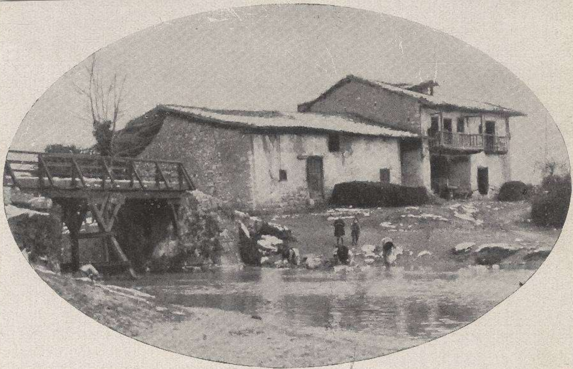
NOREÑA.—Puente de Arrabalde.
