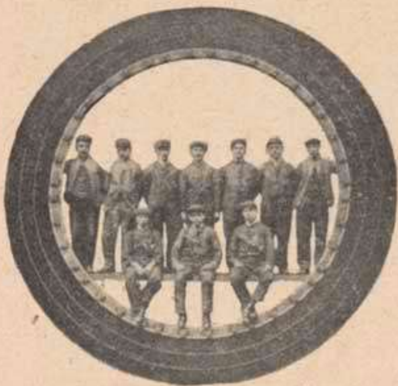
Segmento de una turbina de vapor. (Com- párese con el tamaño de los obreros)
