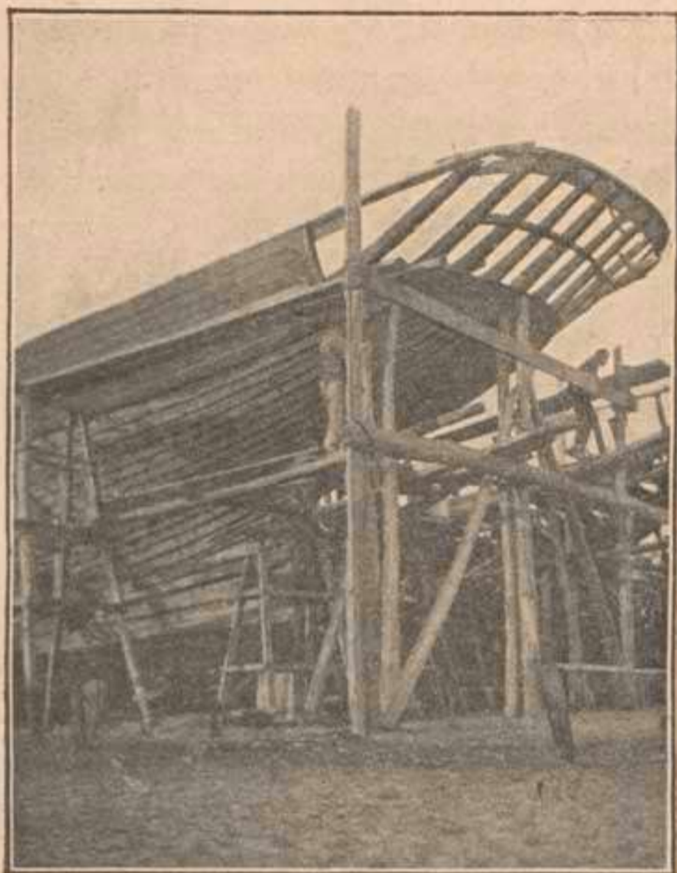
Los «carpinteros de ribera» cubriendo el casco del velero en construcción
