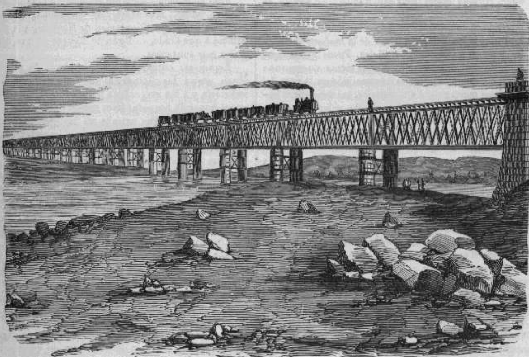
Vista del puente del rio Aragon.
