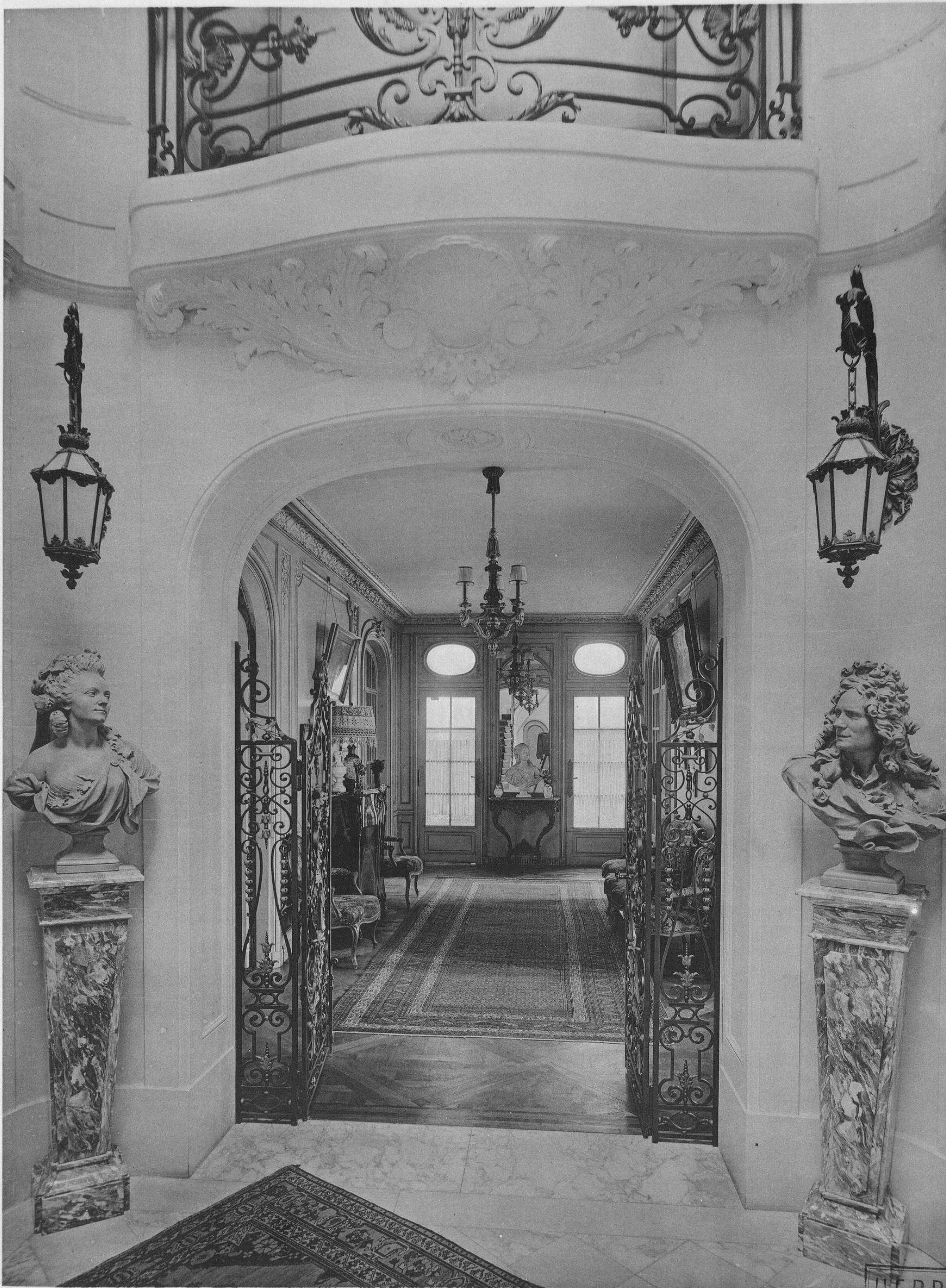
Appartement disposé en Hôtel particulier au 6 e étage d'une maison de rapport à Paris. — Architecte M. Adda. Vestibule.
