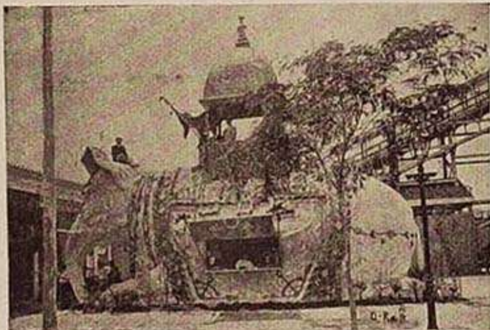
Instalación del kiosco El Elefante
