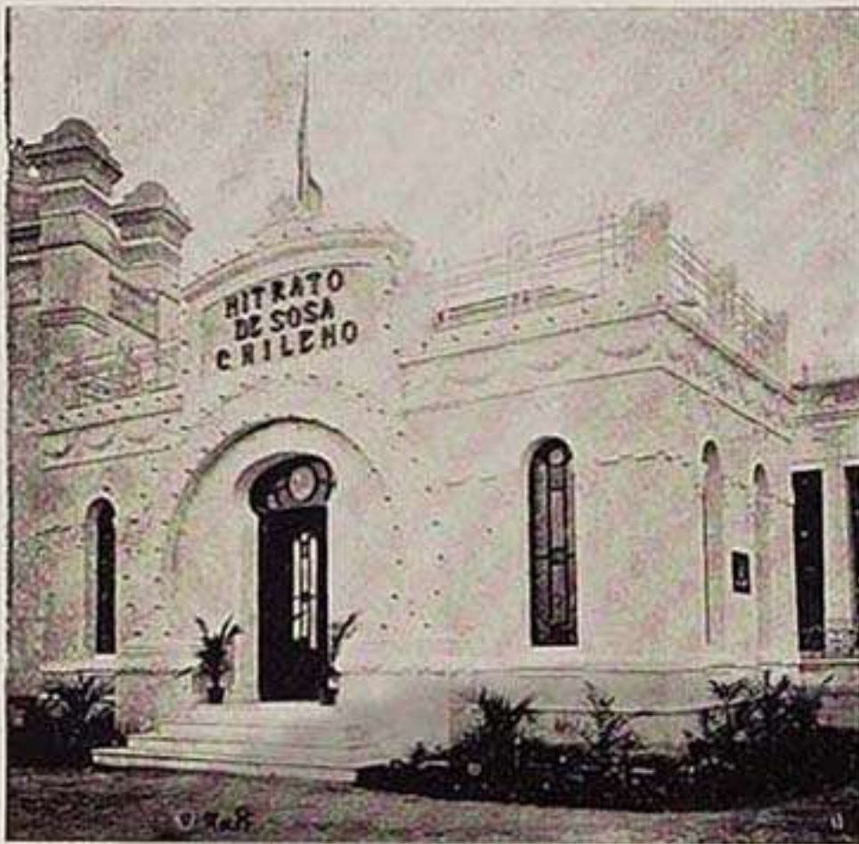
Vista de la instalación en la Exposición
