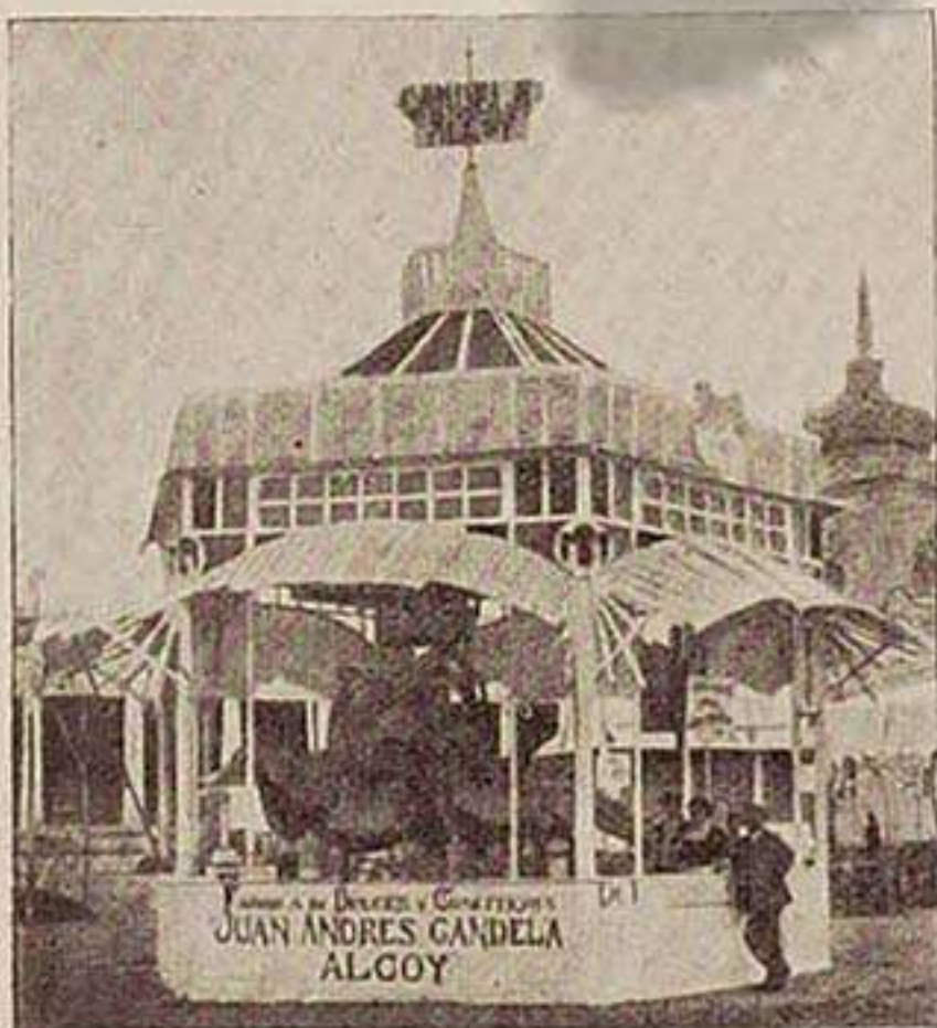
Pabellón de Juan Andrés Candela, Explanada de la izquierda frente á la sala de Máquinas
