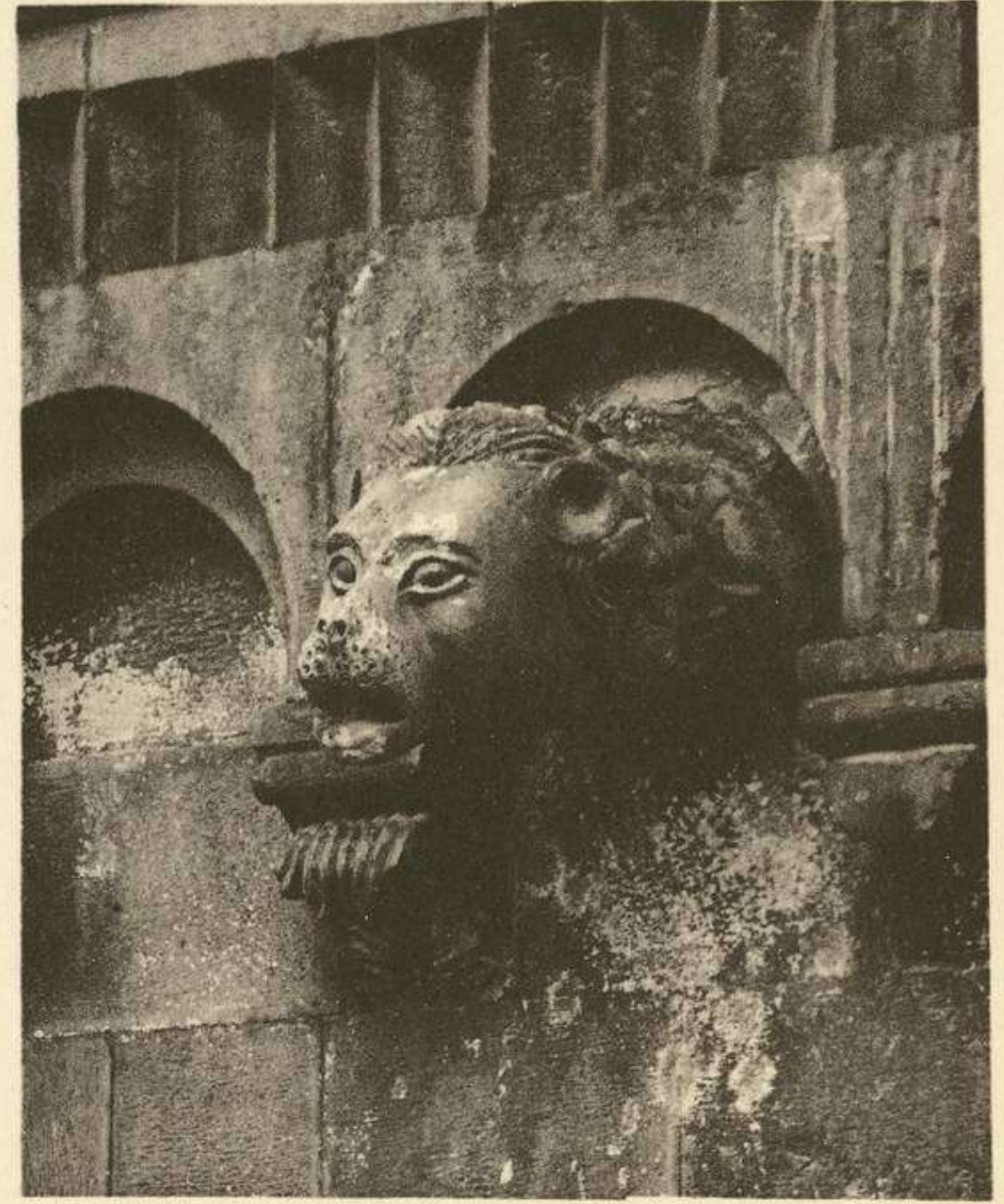
Trogir. Stolna crkva. Potankosti pročelja.
