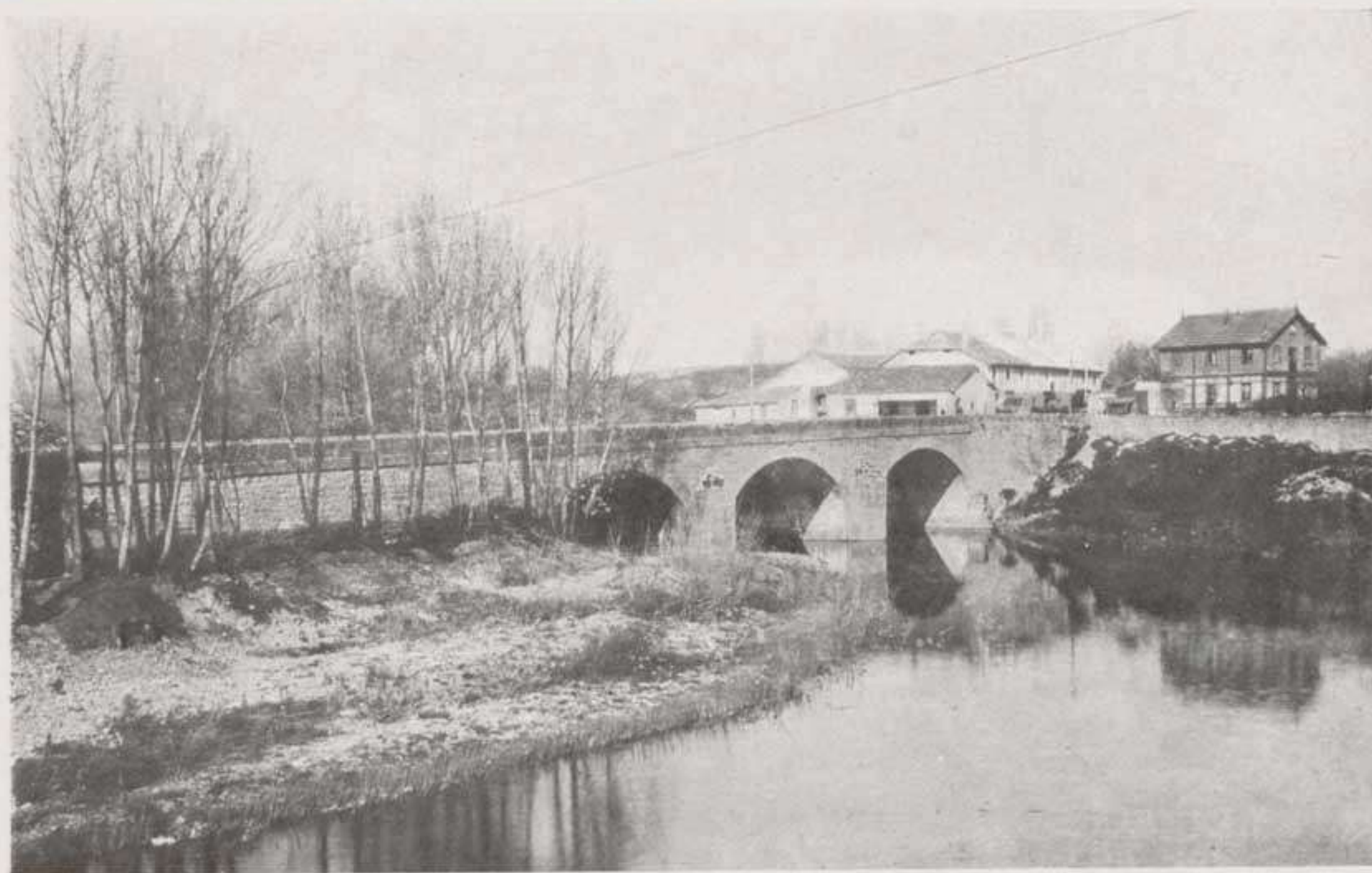
Se halla extendido sobre el río Arga y consta de tres robustos arcos de sillería.
