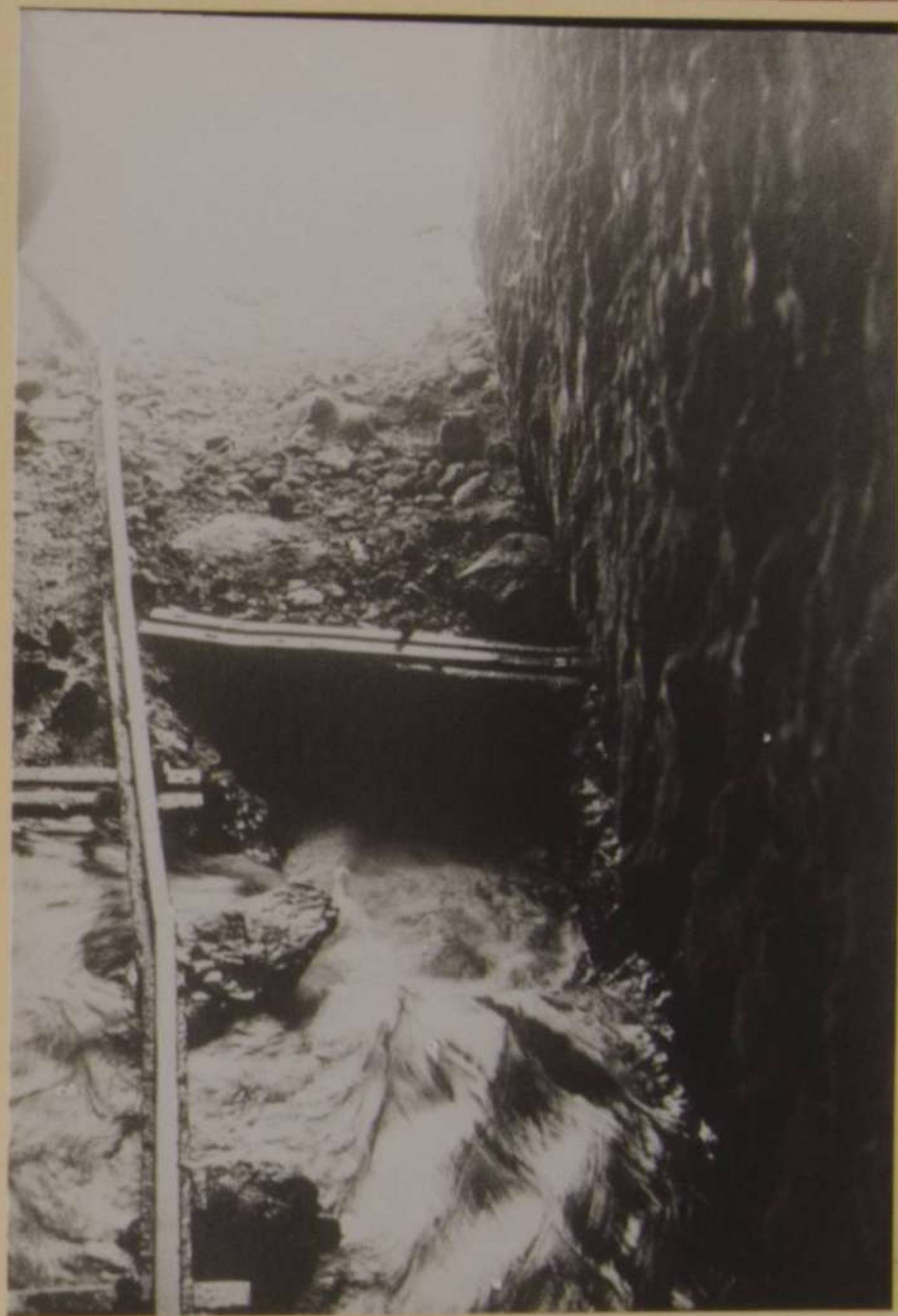
GAMONAL.—SALIDA DEL AGUA EN LA GALERIA PARA SU INCORPORACION AL ABASTO DE LA CIUDAD.
