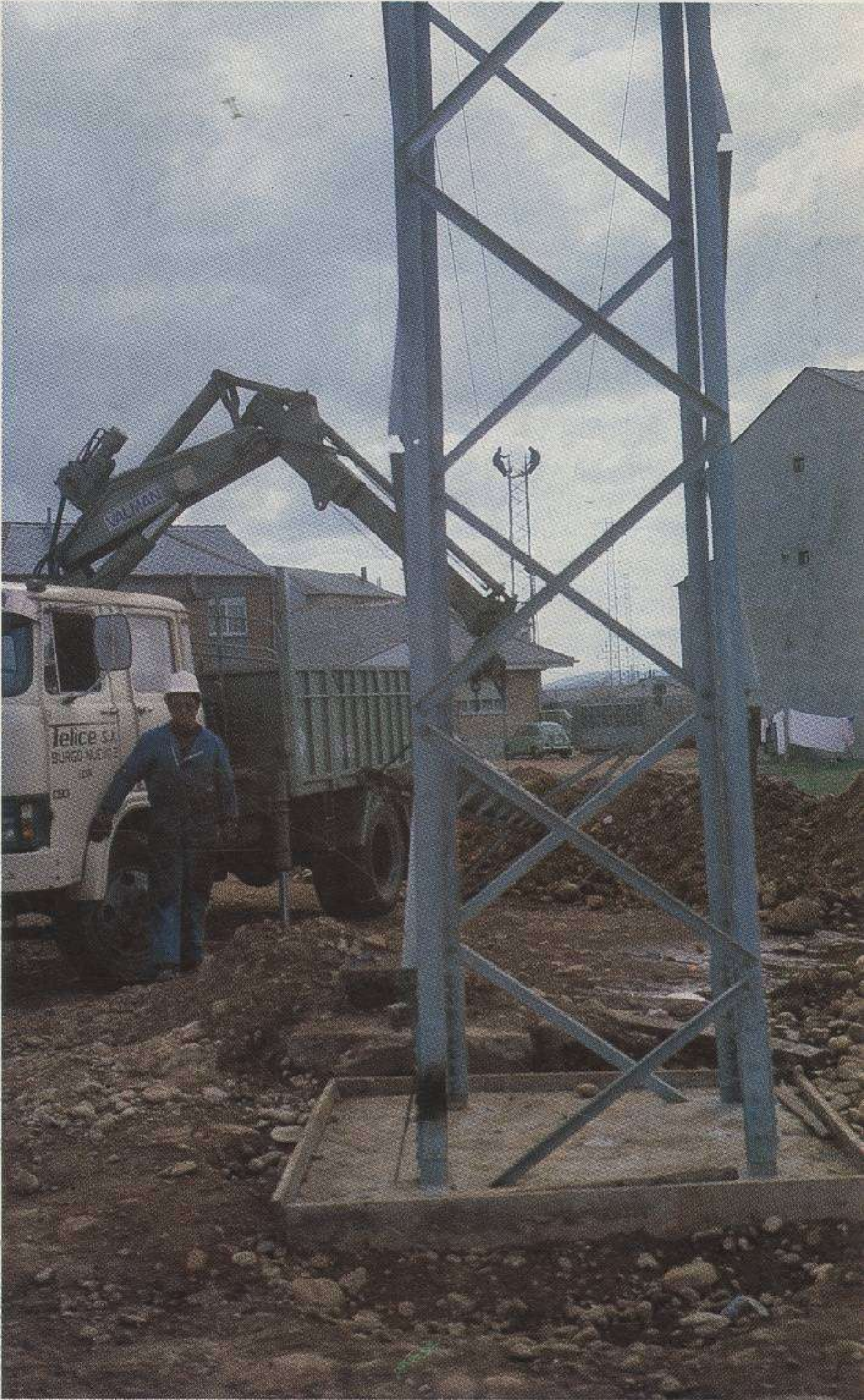
Montaje de una línea de 45 Kv. para RENFE en Ponferrada
