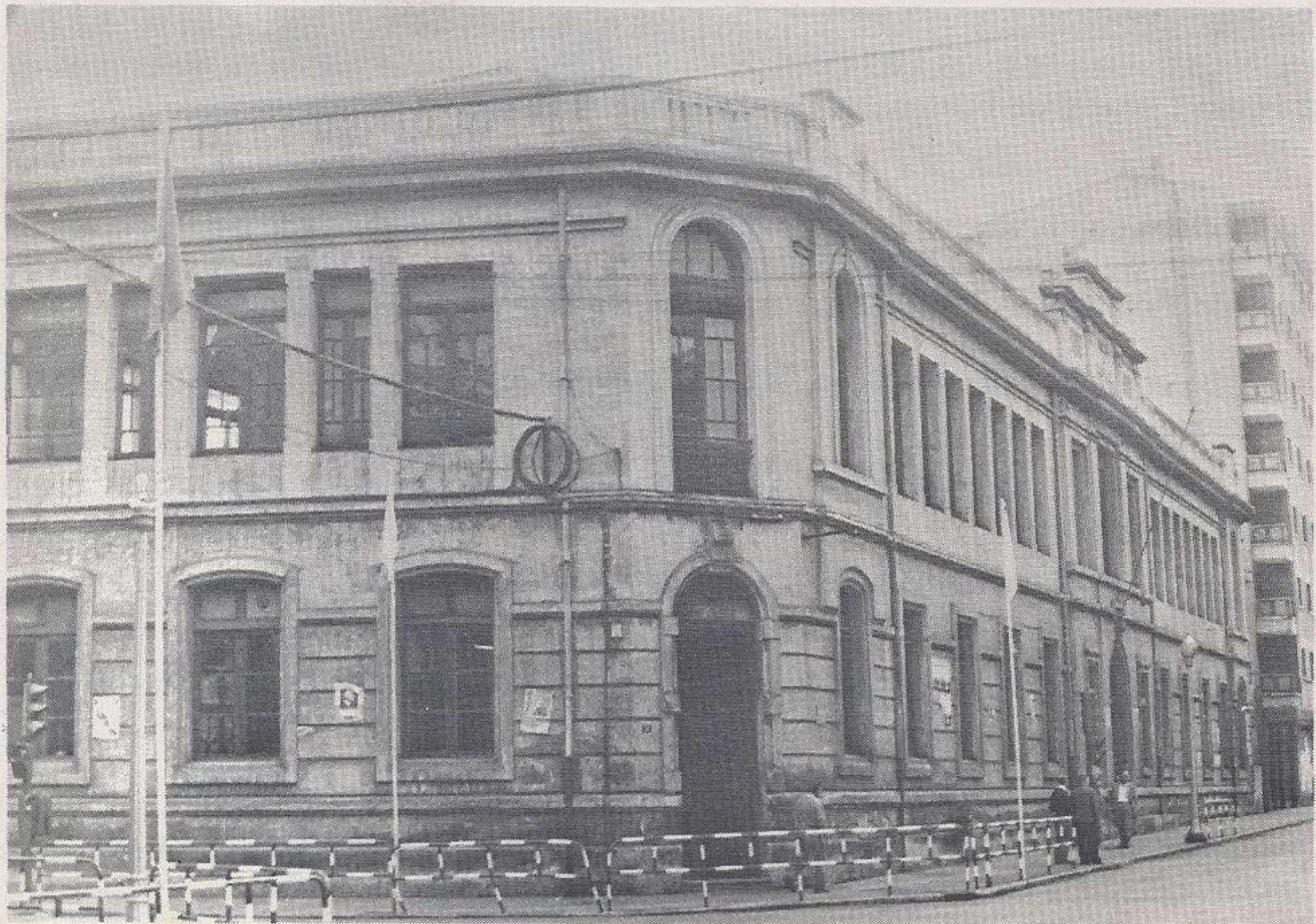
M.E.C.D. 2015 ESCUELA DE ARTES Y OFICIOS. PRIMER EDIFICIO DEL CENTRO
