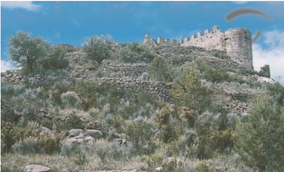
Foto 14. Aspecto de la construcción por su parte posterior.
