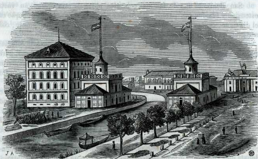
Canal del Sur.
