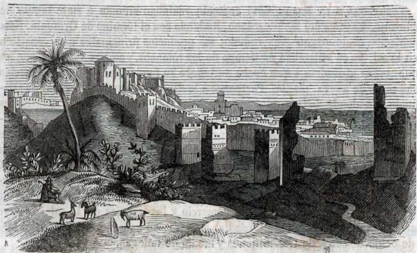
Vista general de Almería.
