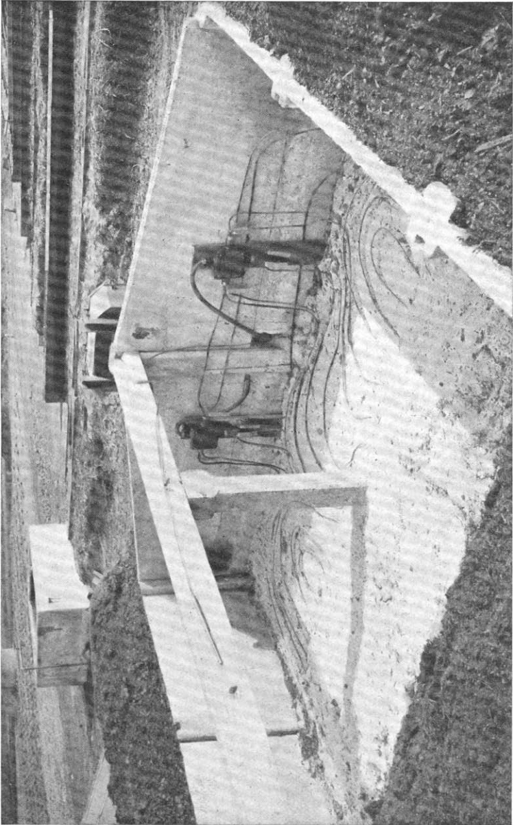
Siemens.—Disposición de los cables de calefacción en una cajonera eléctrica.
