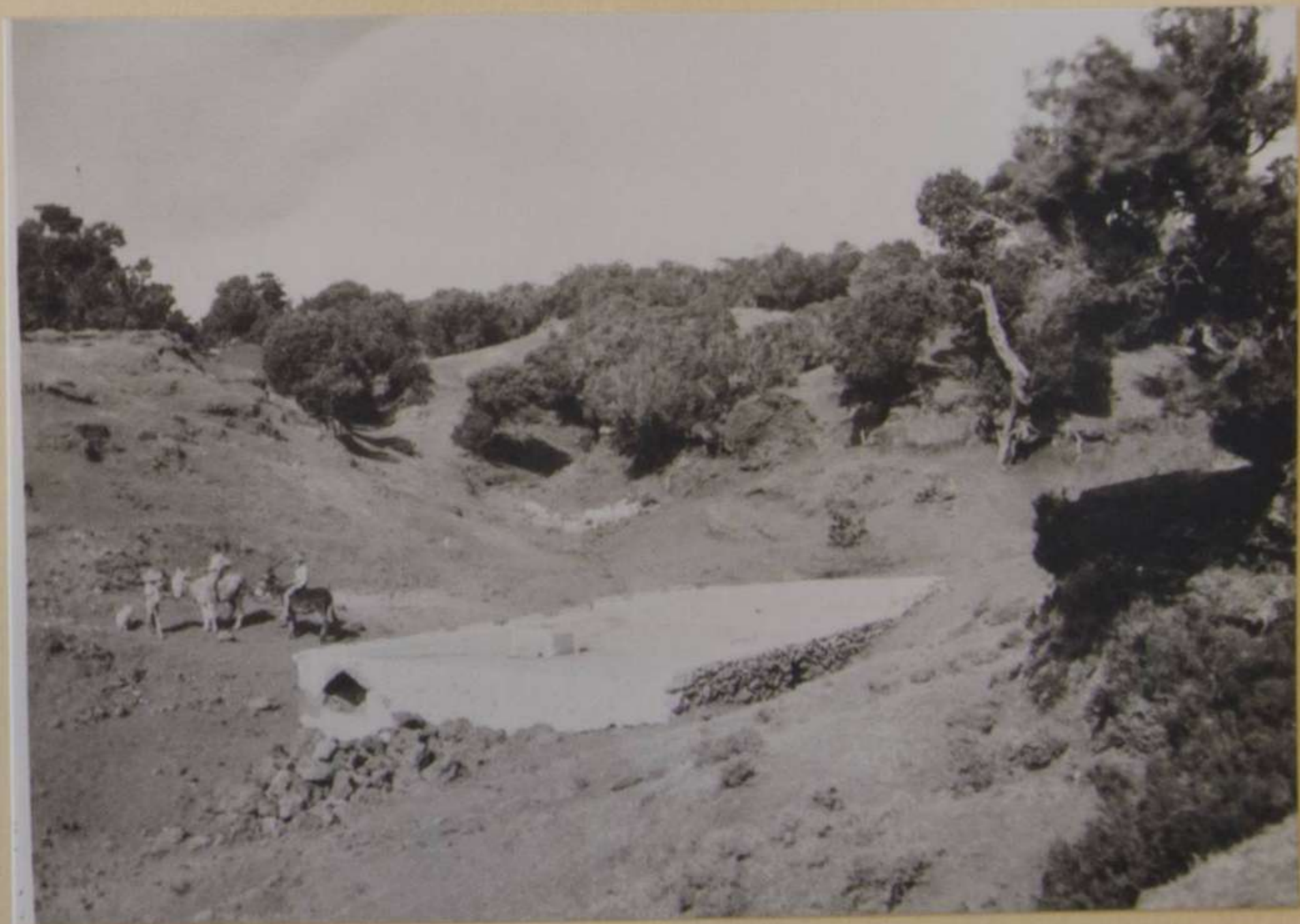
VISTA DEL ALJIBE EN LA LLANTA (HIERRO).-COSTO PTAS. 5.000. — AÑO 1943.
