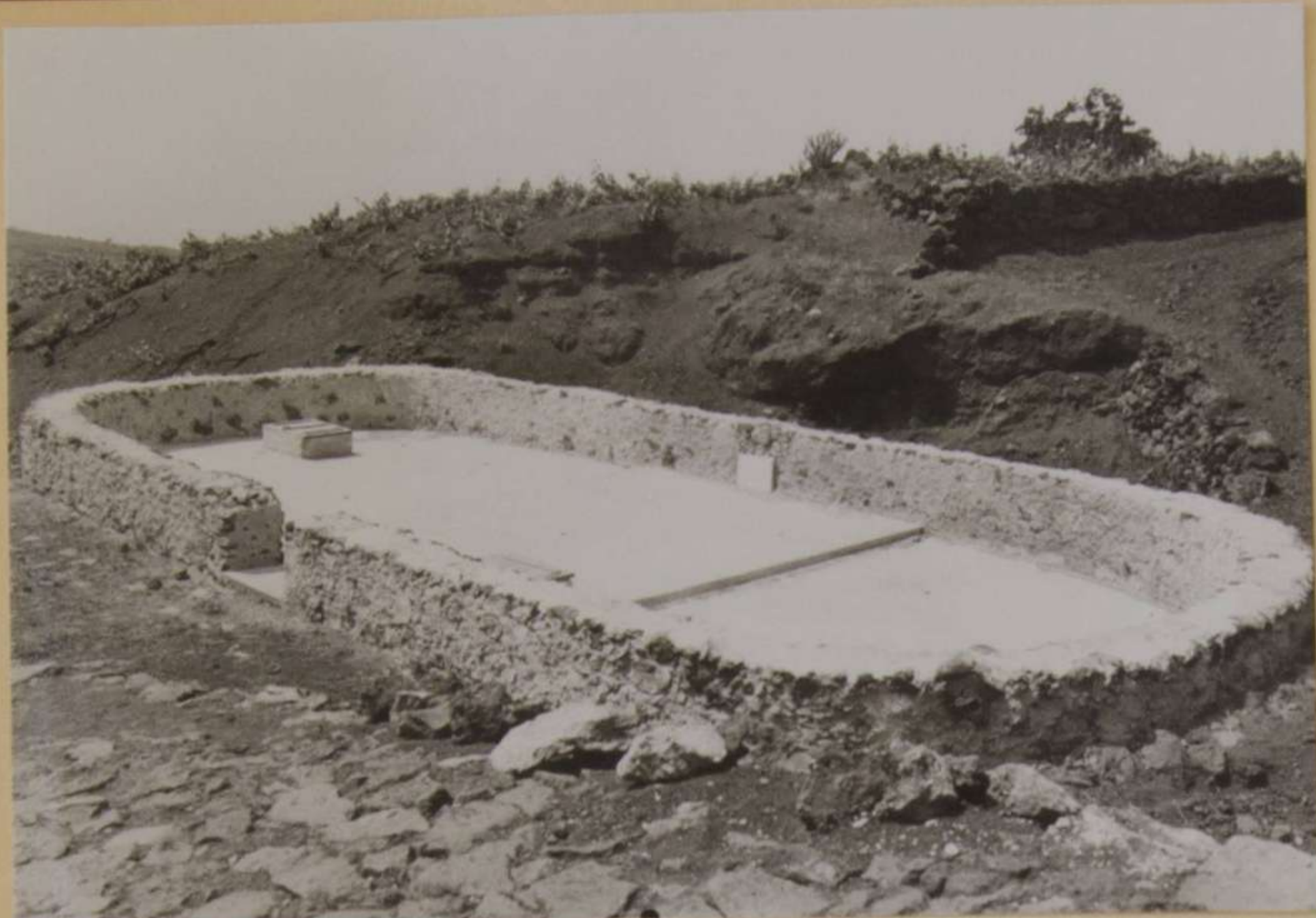
VISTA DEL ALJIBE EN VERGARA-FRONTERA (HIERRO).-COSTO PTAS. 7.500. — AÑO 1943.
